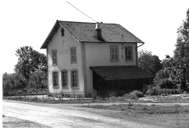
Ecole située 8 chemin du Sel. Phot. Yves Sancey IVR43_19802500931X
