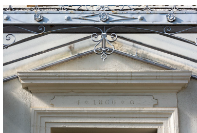
Logement : lindeau daté. Phot. Sonia Dourlot IVR43_20192501332NUC4A
