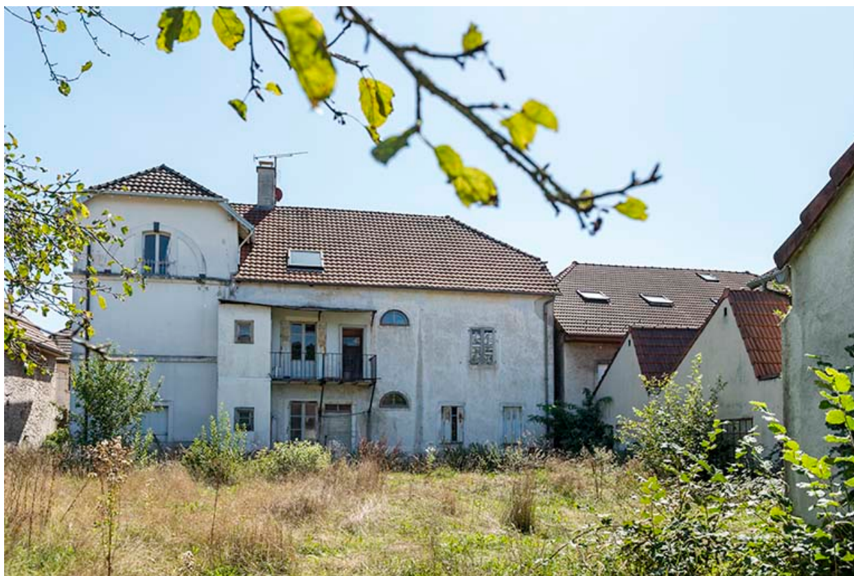
Logement : façade postérieure.
