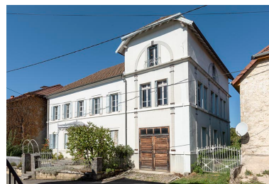
Logement, de trois quarts droite. Phot. Sonia Dourlot IVR43_20192501329NUC4A
