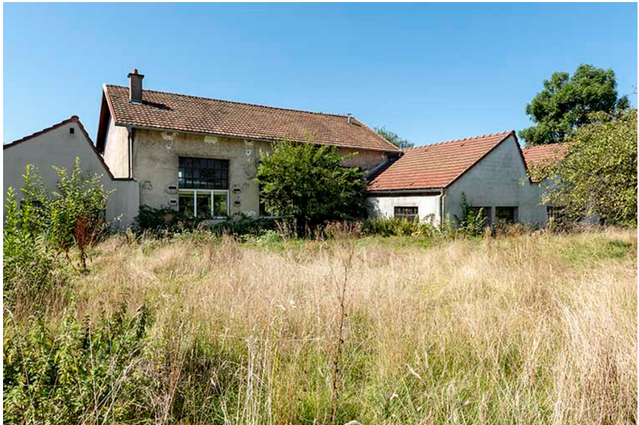
Usine : façade postérieure des ateliers (depuis l'est).
