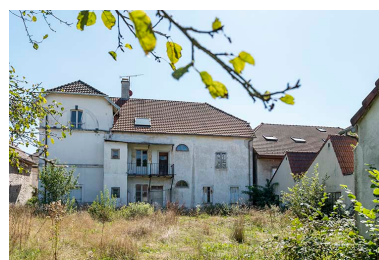
Logement : façade postérieure. Phot. Sonia Dourlot IVR43_20192501330NUC4A
