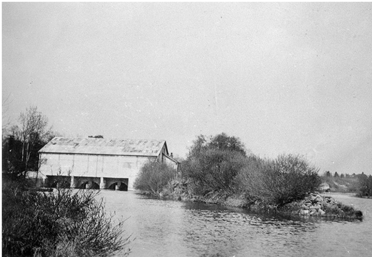
Station. Canal de fuite.
