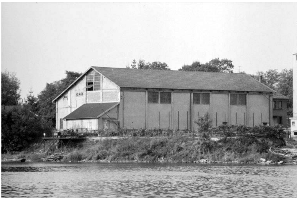
Centrale hydroélectrique, depuis l'est.
