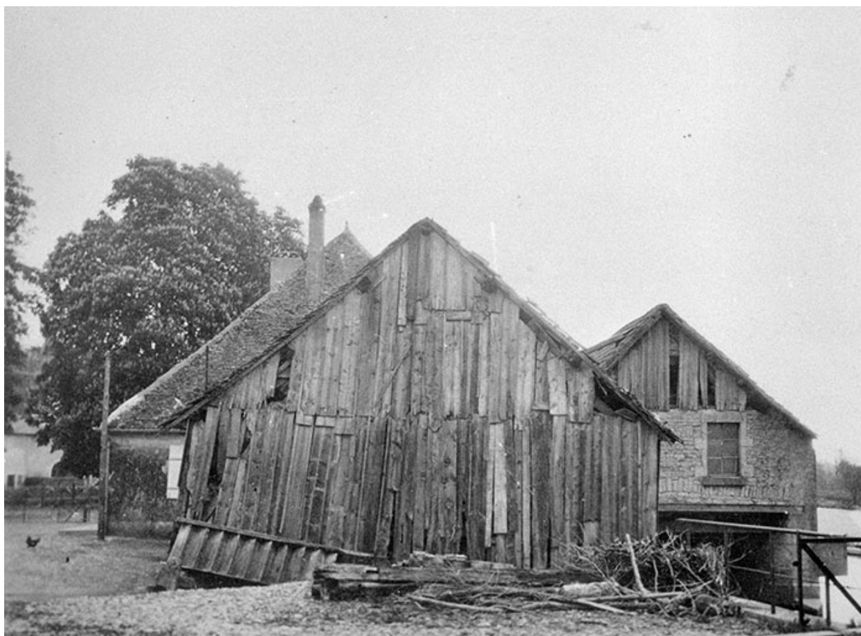
Moulin. Façade côté Usine.
