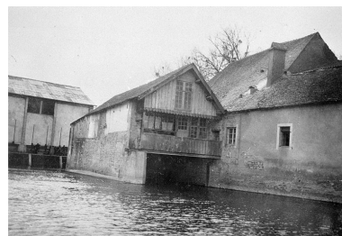
Moulin. Côté canal d'amenée. Phot. Yves Sancey IVR43_19883900583Z
