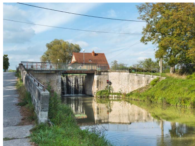
Vue d'ensemble du pont.
