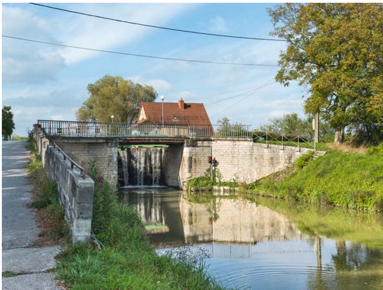
Vue d'ensemble du pont.
