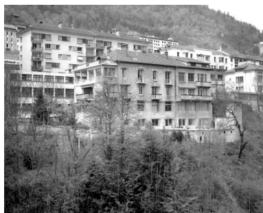
Logements et bureau depuis le sud.
