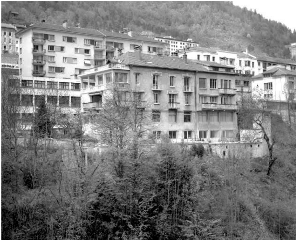
Logements et bureau depuis le sud.
