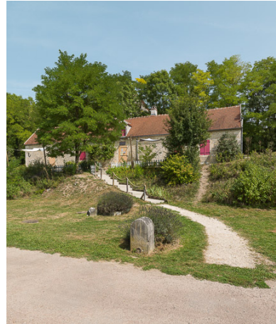
Vue de la maison éclusière. Phot. Pierre-Marie Barbe-Richaud IVR26_20178900131NUC2A
