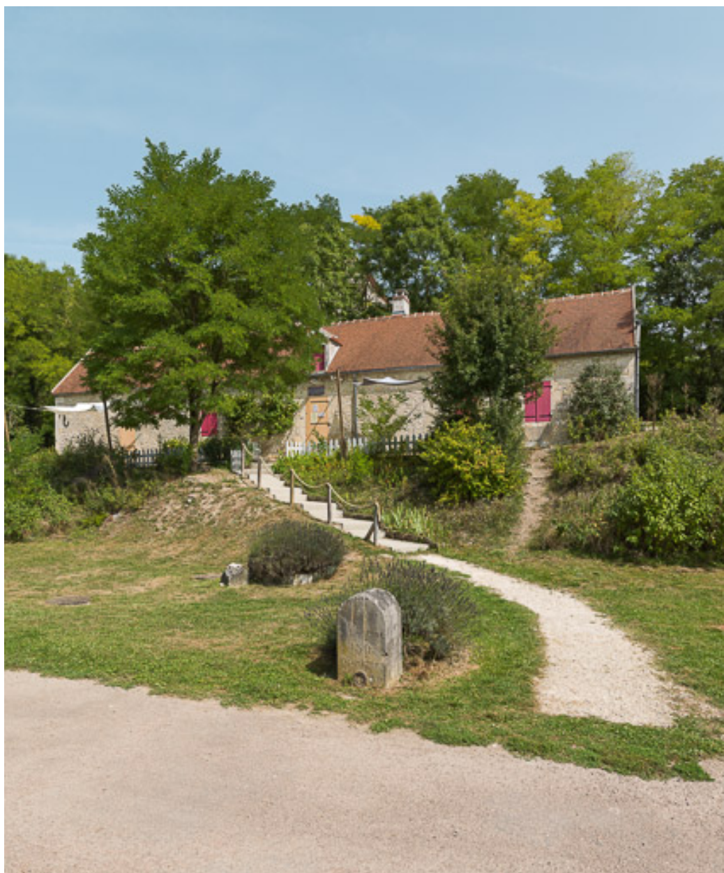
Vue de la maison éclusière.
