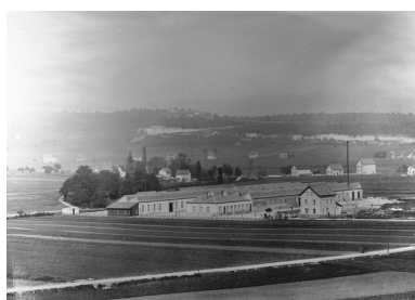
L'usine en construction. Photogr., s.n., s.d. [vers 1898]. Autr. IVR43_20122501469NUC2
