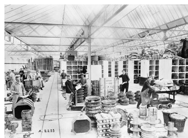
Magasins de stockage de pièces. Photogr., s.n., s.d. [vers 1912]. Autr. IVR43_20122501490NUC2
