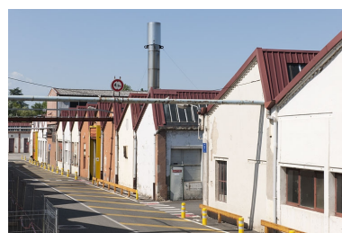
Pignons des ateliers ouest. Phot. Jérôme Mongreville IVR43_20112502114NUC4A
