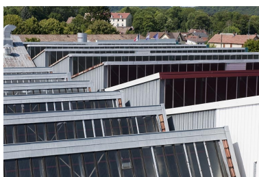
Toitures de l'atelier de fabrication ouest. Phot. Jérôme Mongreville IVR43_20112502130NUC4A
