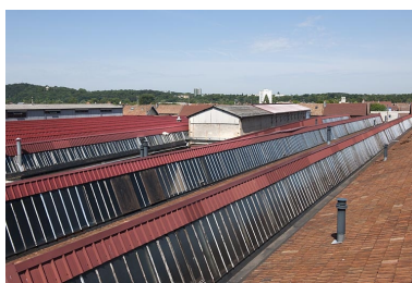
Sheds de l'atelier de montage des voitures. Phot. Jérôme Mongreville IVR43_20112502118NUC4A
