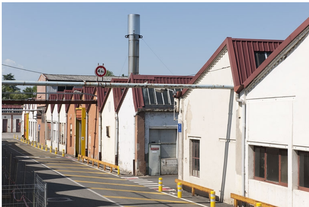
Pignons des ateliers ouest.
