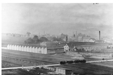
Vue d'ensemble depuis le nord-est. Photogr., s.n., s.d. [début du 20e siècle]. Autr. IVR43_20122501470NUC2
