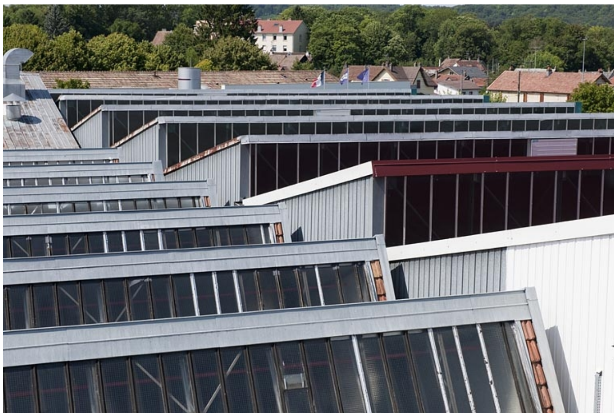
Toitures de l'atelier de fabrication ouest.
