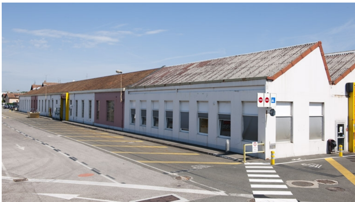
Façade sud de l'atelier des tours.
