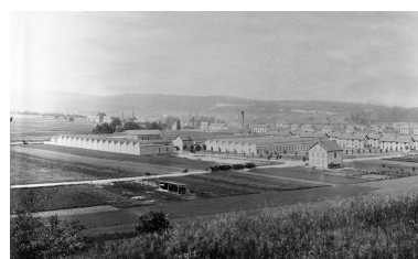
Vue éloignée depuis le nord-est. Photogr., s.n., s.d. [début du 20e siècle]. IVR43_20122501471NUC2
