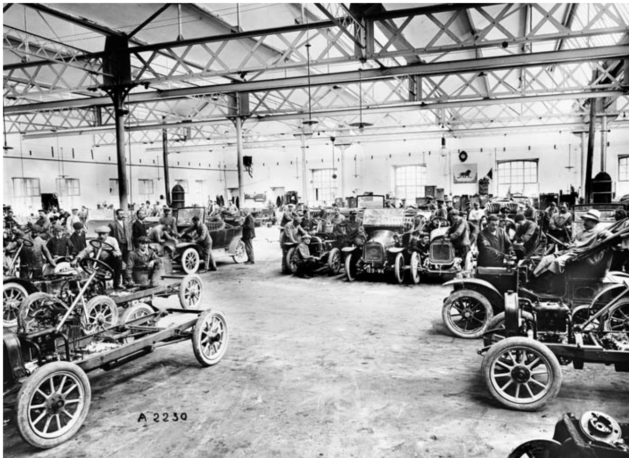
Atelier (carrossage ?). Photogr., s.n., s.d. [vers 1910].
