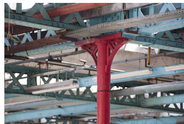
Atelier des boîtes de vitesses. Détail d'une console d'une colonne en fonte.
