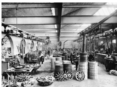
Usine d'Audincourt (?). Atelier de fabrication des roues. Photogr., s.n., s.d. [début 20e siècle]. Autr. IVR43_20122501477NUC2
