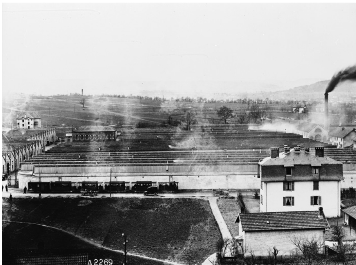
Sheds de l'usine depuis le nord. Photogr., s.n., s.d. [début du 20e siècle].
