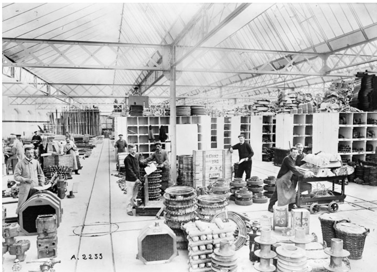
Magasins de stockage de pièces. Photogr., s.n., s.d. [vers 1912].
