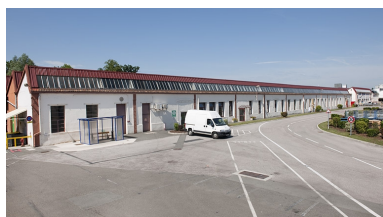
Ateliers de fabrication ouest. Façade sur cour. Phot. Jérôme Mongreville IVR43_20112502122NUC4A
