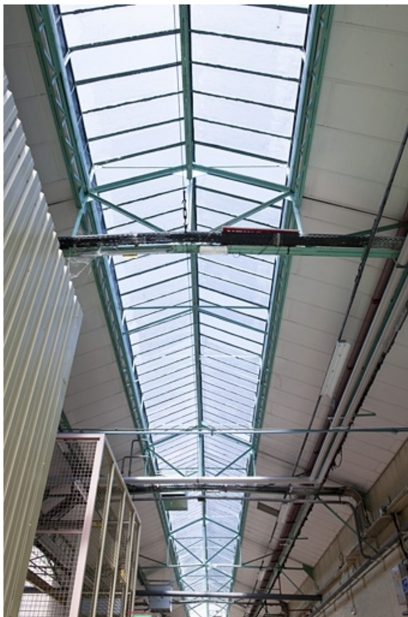
Atelier ou magasin (?). Vue sur la charpente et le lanterneau.
