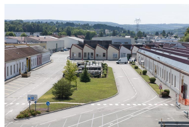
Vue rapprochée depuis le nord-ouest. Phot. Jérôme Mongreville IVR43_20112502129NUC4A
