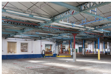
Ossature métallique de l'atelier des boîtes de vitesses.
