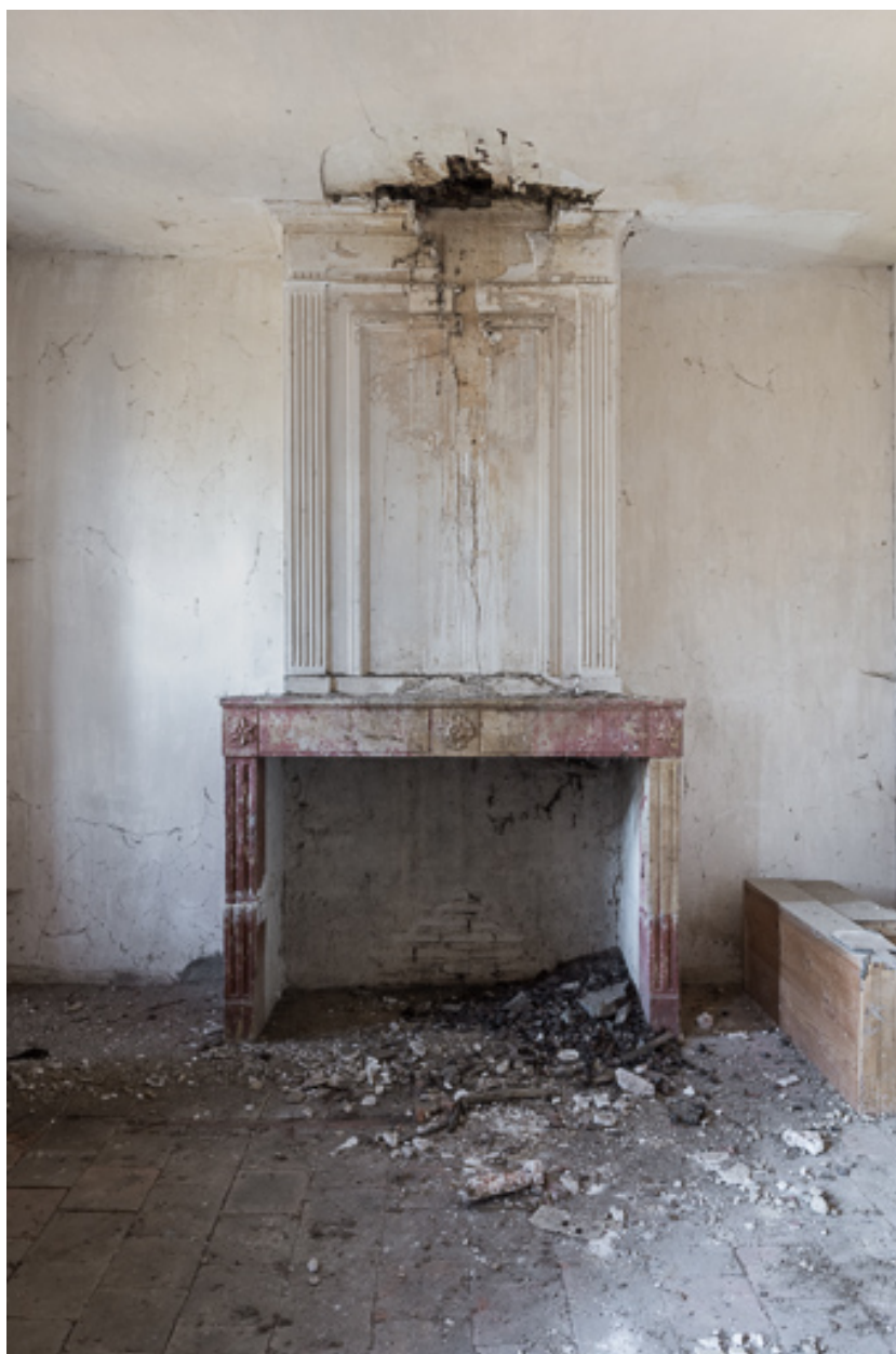
Vue de la cheminée de cette chambre
