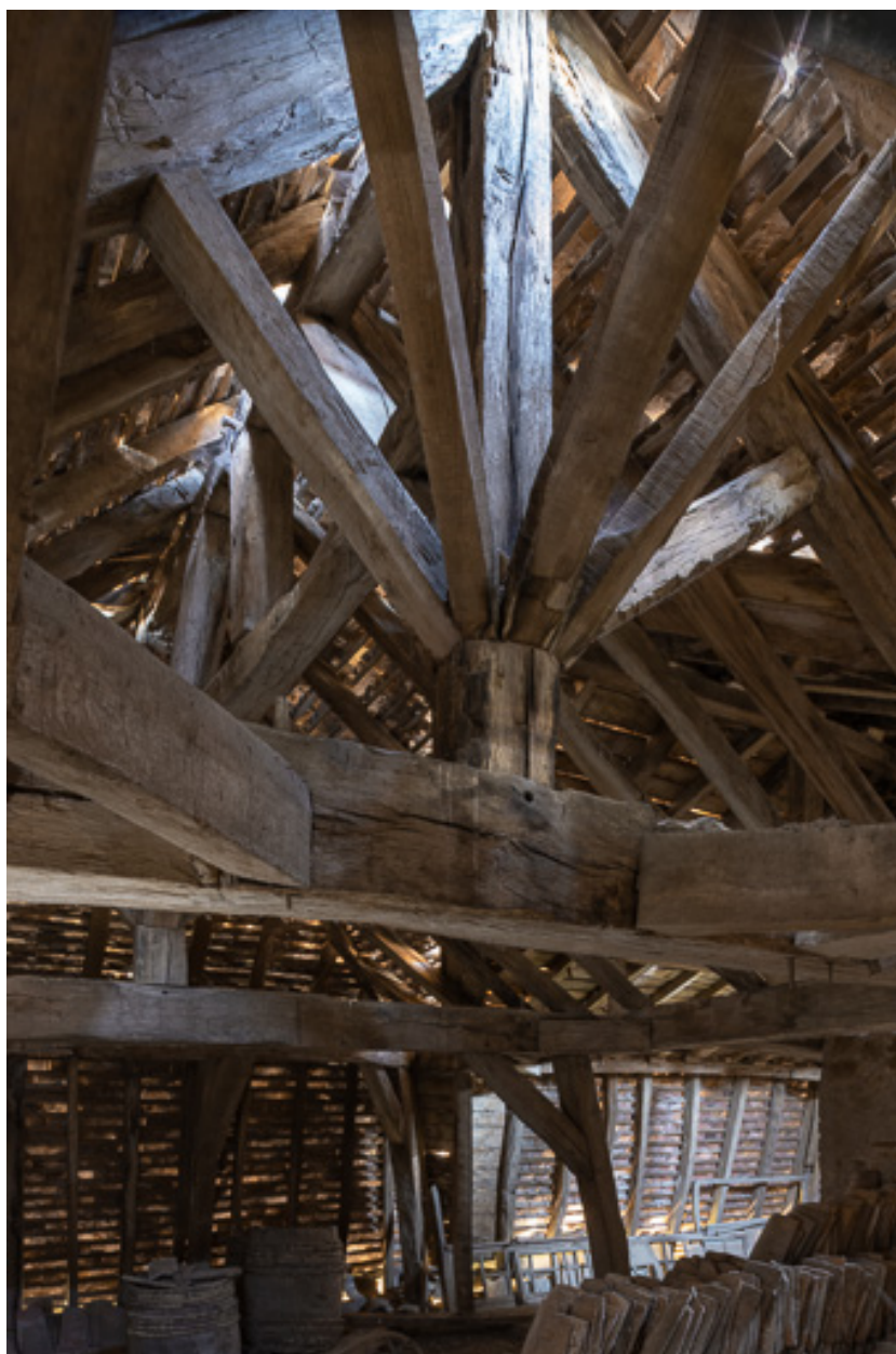
Détail de la charpente : pignon et contrefiches
