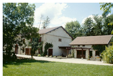
Logement patronal, bâtiment d'eau et ancienne scierie. Phot. Laurent Poupard IVR43_19883900561ZA
