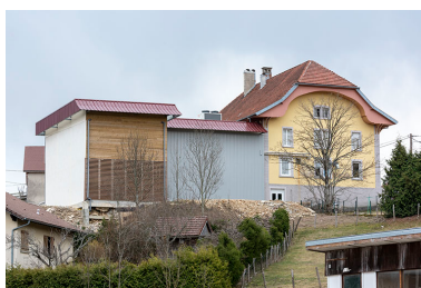
Façade latérale gauche et extension, depuis l'ouest. Phot. Sonia Dourlot IVR43_20192500467NUC4A
