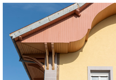
Façade latérale droite : détail de l'avant-toit et de ses consoles. Phot. Sonia Dourlot IVR43_20192500465NUC4A
