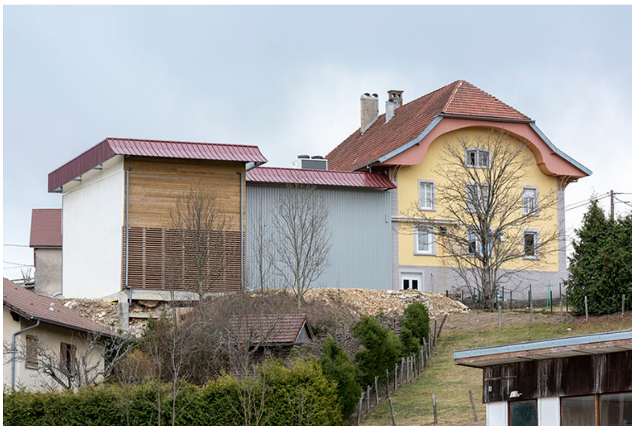
Façade latérale gauche et extension, depuis l'ouest.
