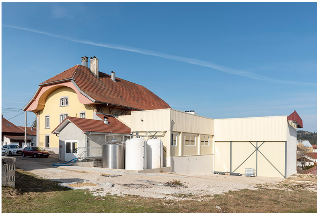
Façade latérale droite et extension, depuis l'est.
