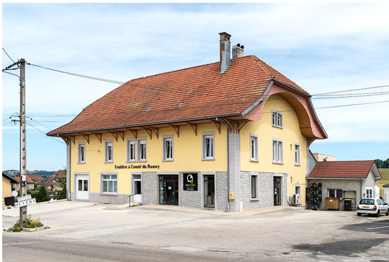
Façades antérieure et latérale droite (après rafraîchissement).
