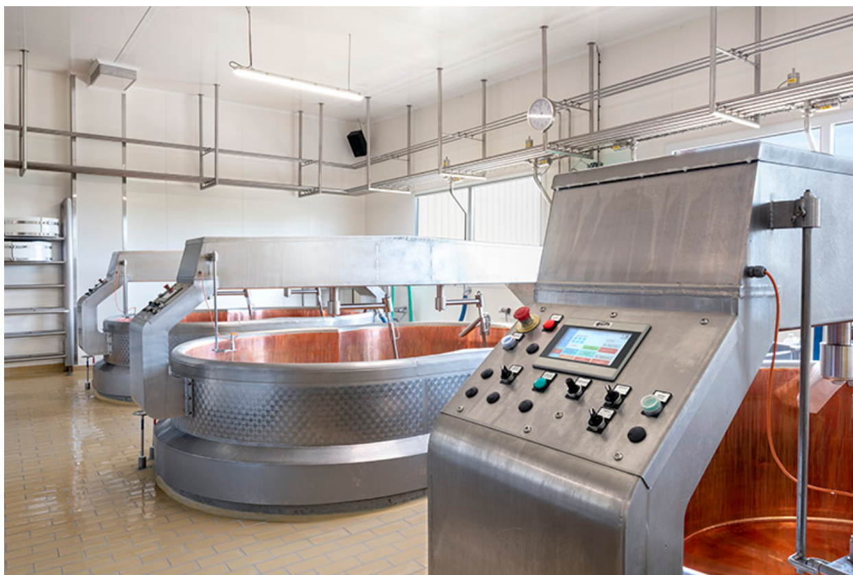
Atelier de fabrication : cuves.
