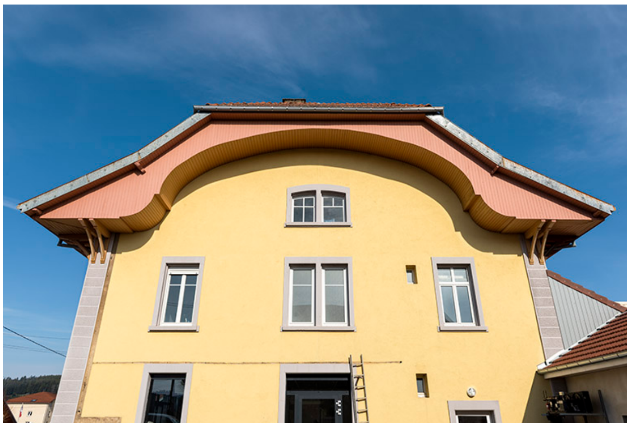
Façade latérale droite, vue en contre-plongée.
