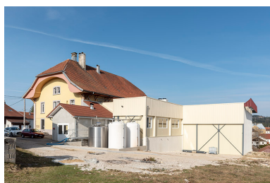
Façade latérale droite et extension, depuis l'est. Phot. Sonia Dourlot IVR43_20192500466NUC4A
