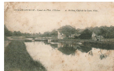
Demangevelle. Canal de l'est. Ecluse. Carte postale. Phot. Jérôme Mongreville IVR43_20157000510NUC4A
