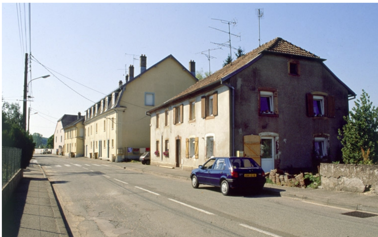
Logements et bureaux depuis la rue d'Andelnans.
