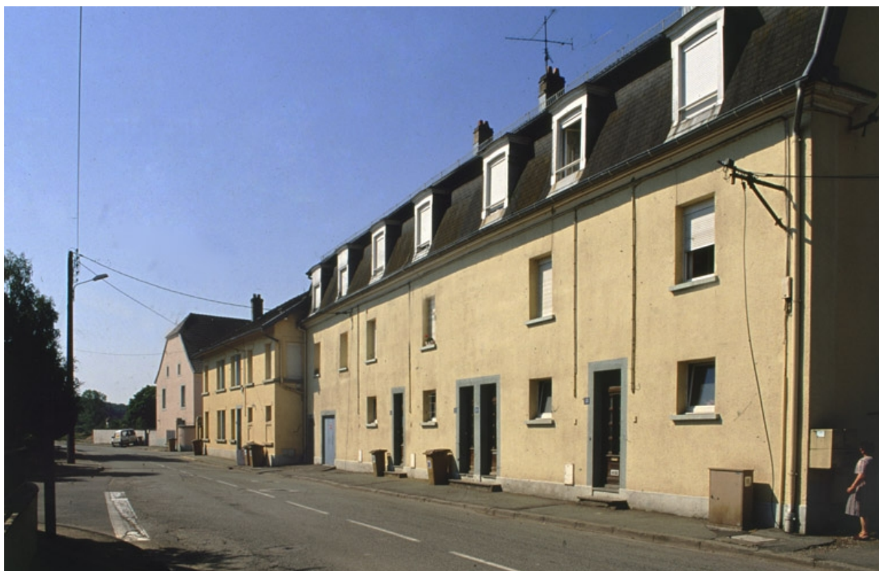
Façades sur rue des logements et bureaux.
