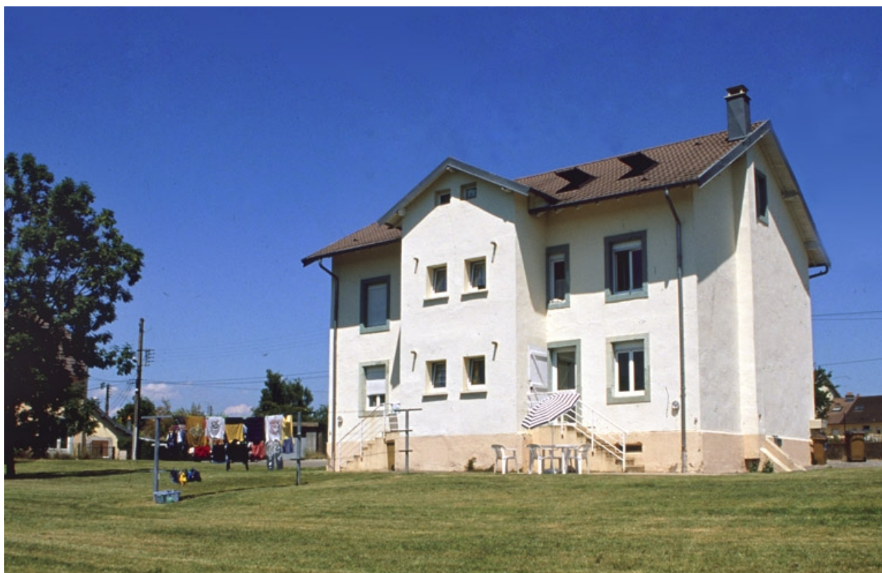
Façade postérieure d'un logement ouvrier.
