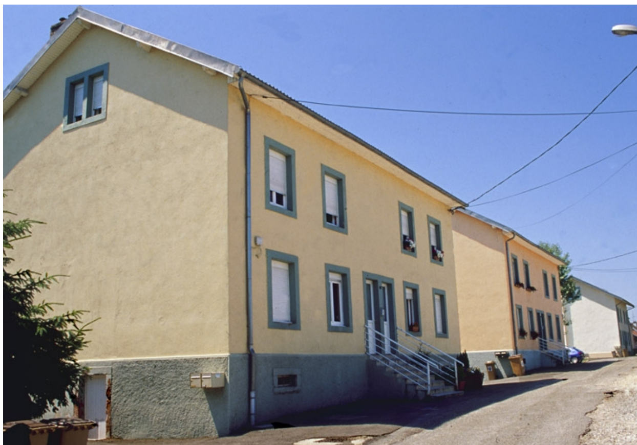
Logements ouvriers rue de la Libération.
