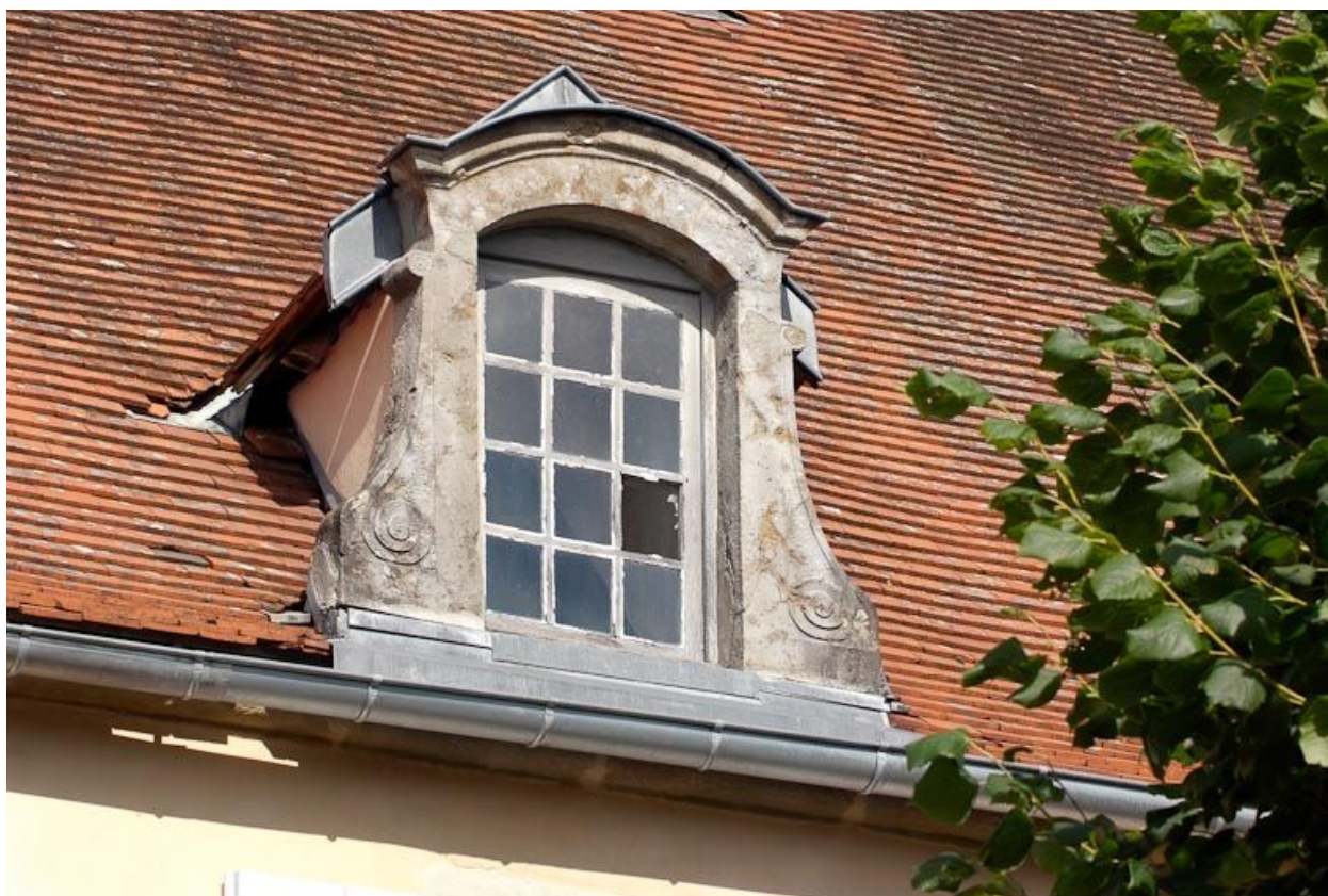
Lucarne de la façade antérieure.
