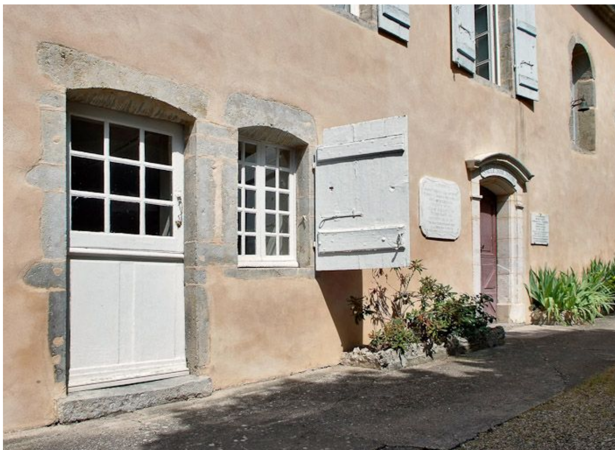
Façade antérieure de l'ancien hôpital, partie centrale.
