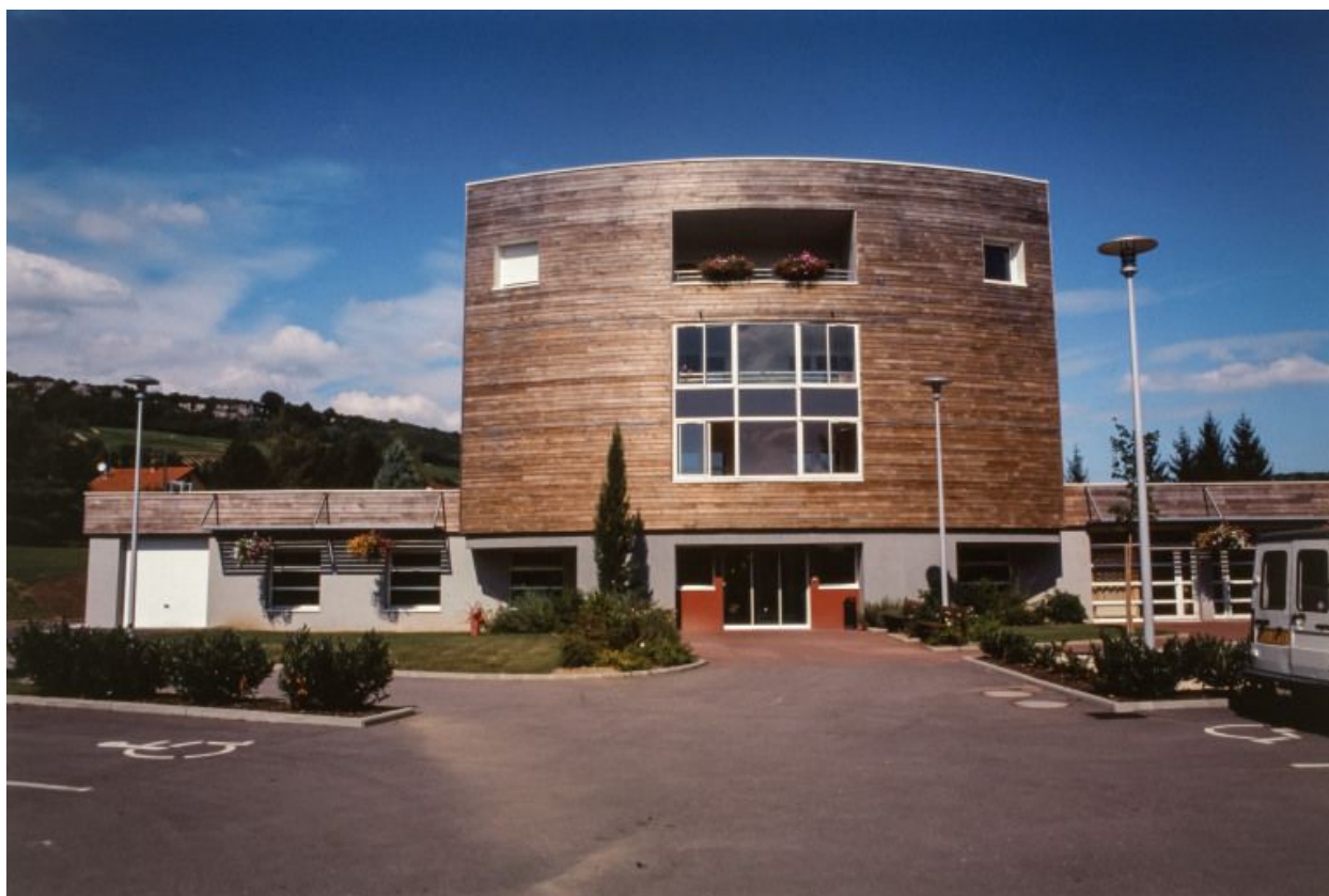
Maison de retraite, élévation antérieure.
