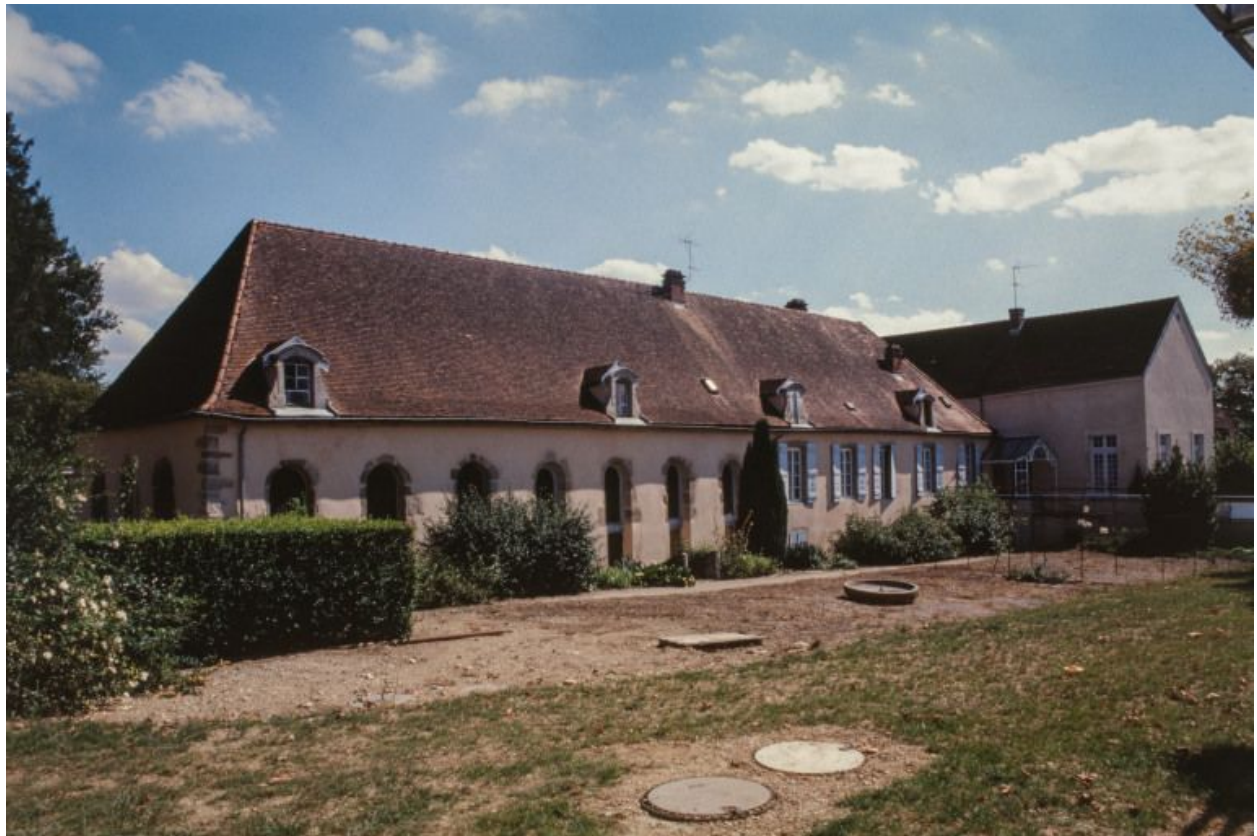
Vue générale de l'ancien hôpital, façade postérieure.
