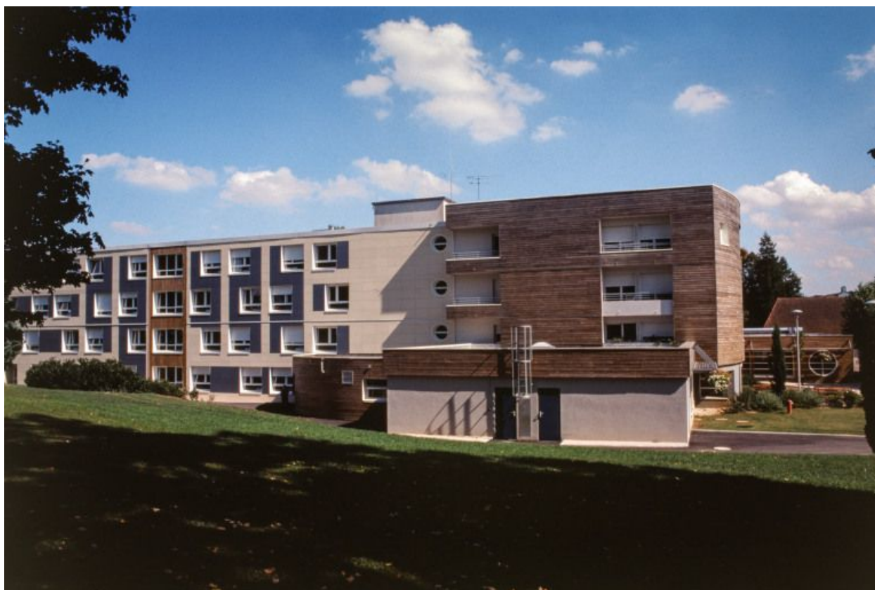
Maison de retraite, élévation latérale.
