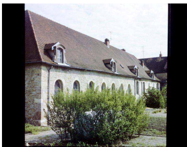
Vue du bâtiment principal. IVR26_19952100035VE
