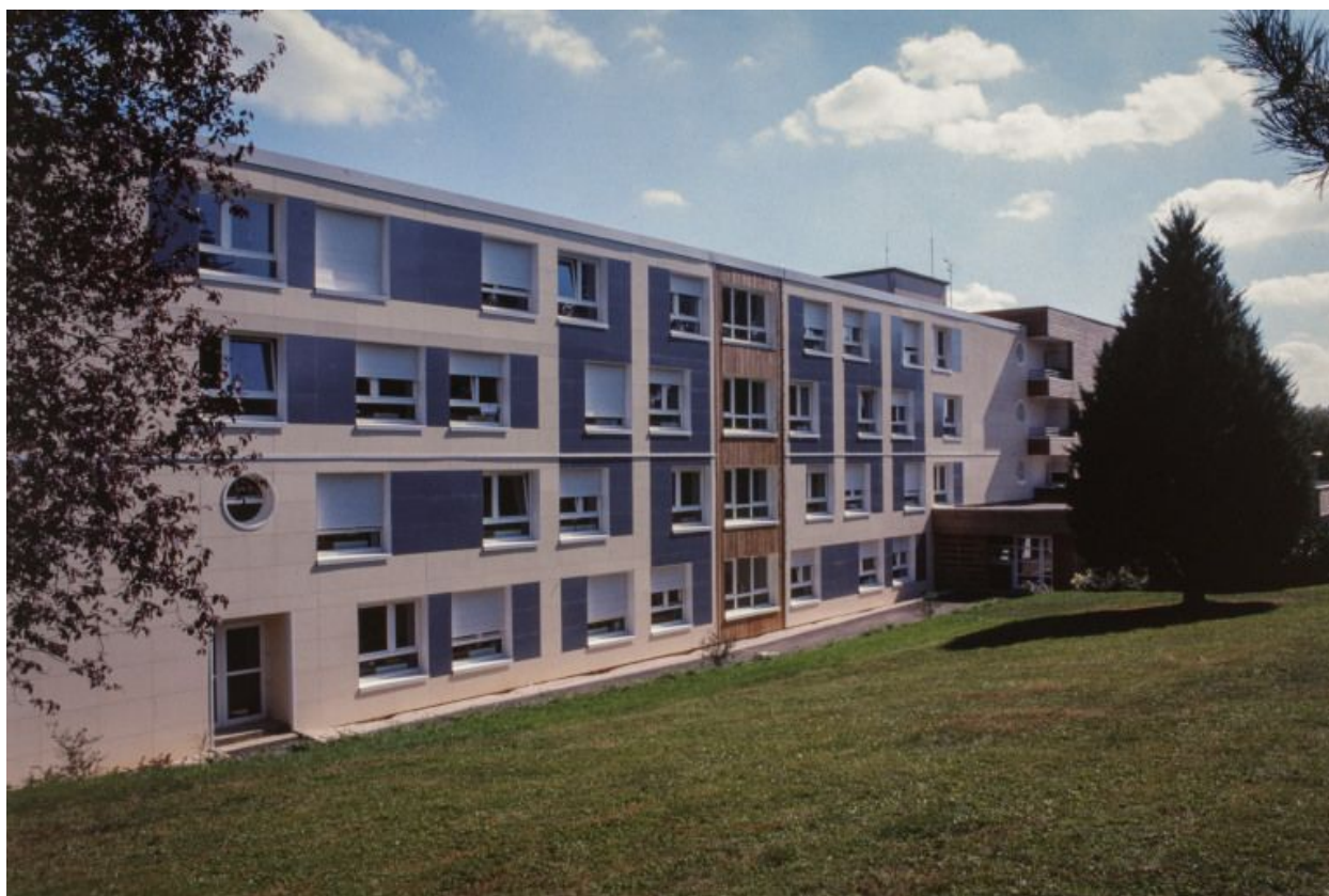
Maison de retraite, élévation latérale.
