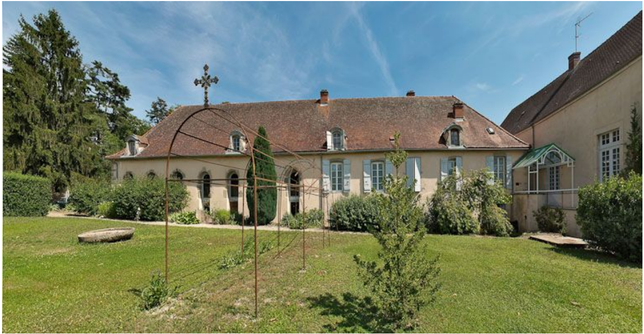
Façade postérieure de l'ancien hôpital.
