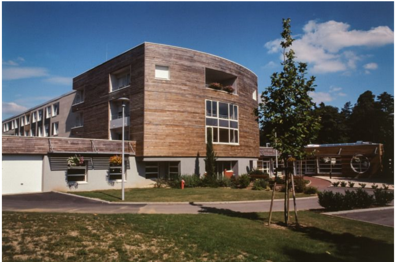
Maison de retraite, élévation antérieure.
