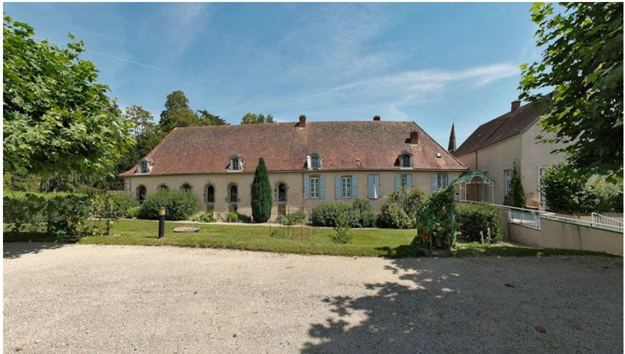
Façade postérieure de l'ancien hôpital.
