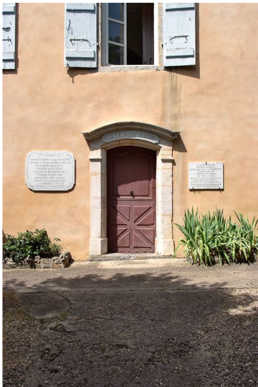
Façade antérieure, détail de la partie centrale.
