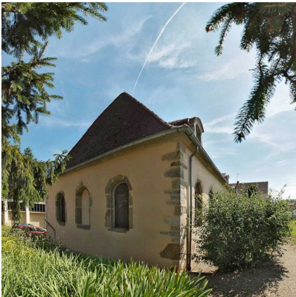
Elévation droite (ancienne chapelle).
