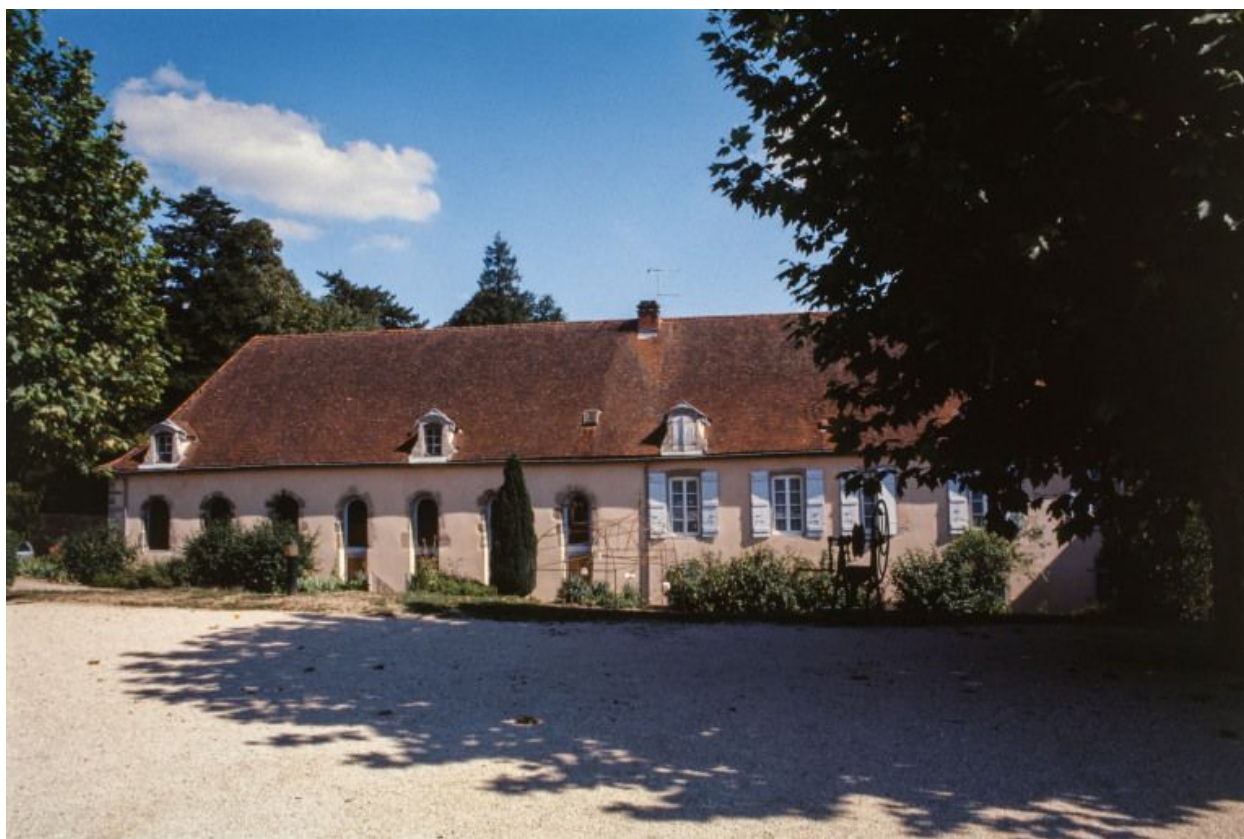
Vue générale de l'ancien hôpital, façade postérieure.
