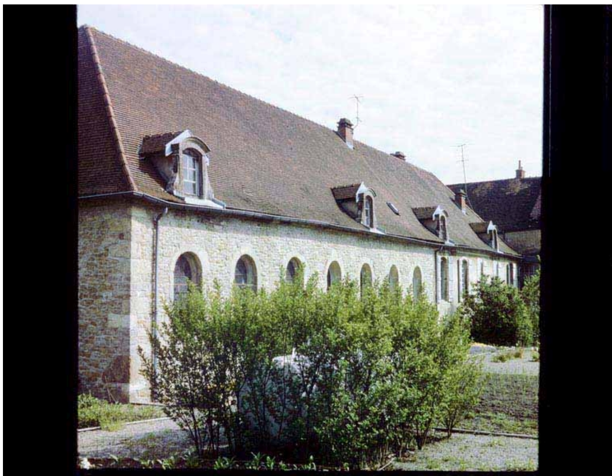
Vue du bâtiment principal.
