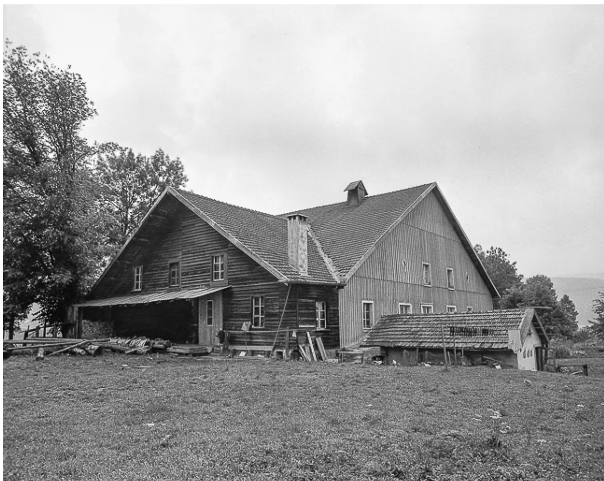
Façades antérieure et latérale droite, en 1976.
