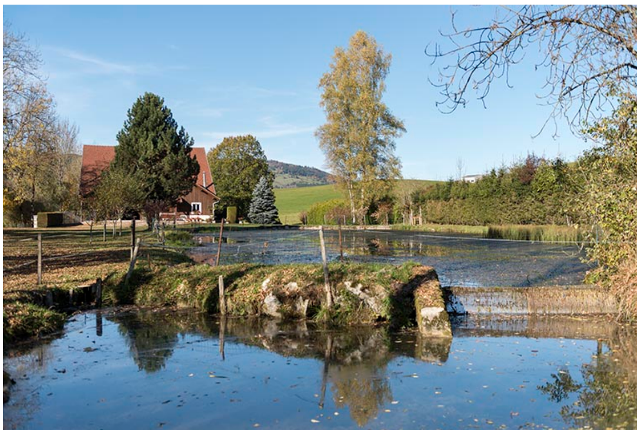
Le bassin de retenue.
