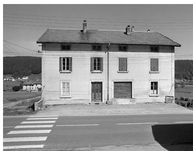
Façade antérieure. Phot. Jérôme Mongreville IVR43_20003900241X
