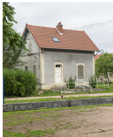
Vue de la maison éclusière. Phot. Pierre-Marie Barbe-Richaud IVR26_20175800429NUC2A
