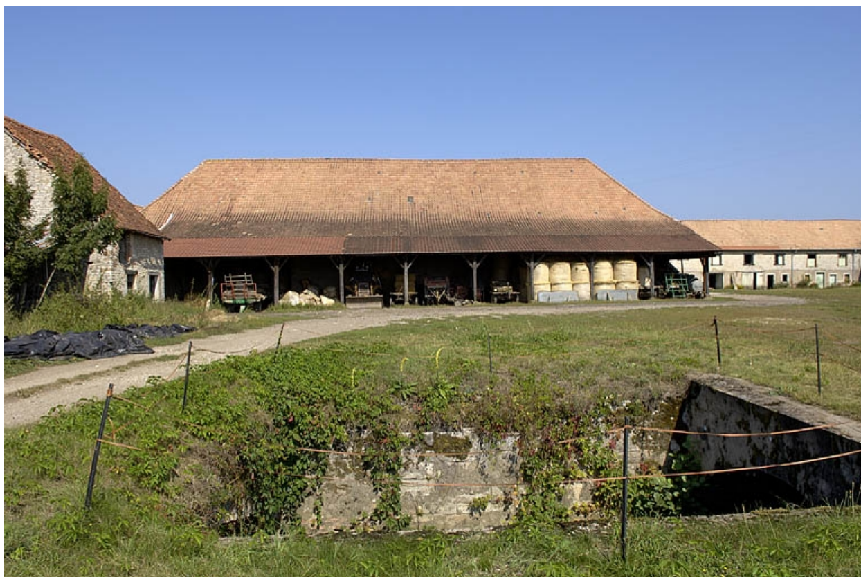
Halle à charbon vue depuis le sud.
