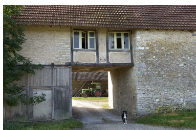
Entrée de l'usine. Phot. Jérôme Mongreville IVR43_20057000464NUCA
