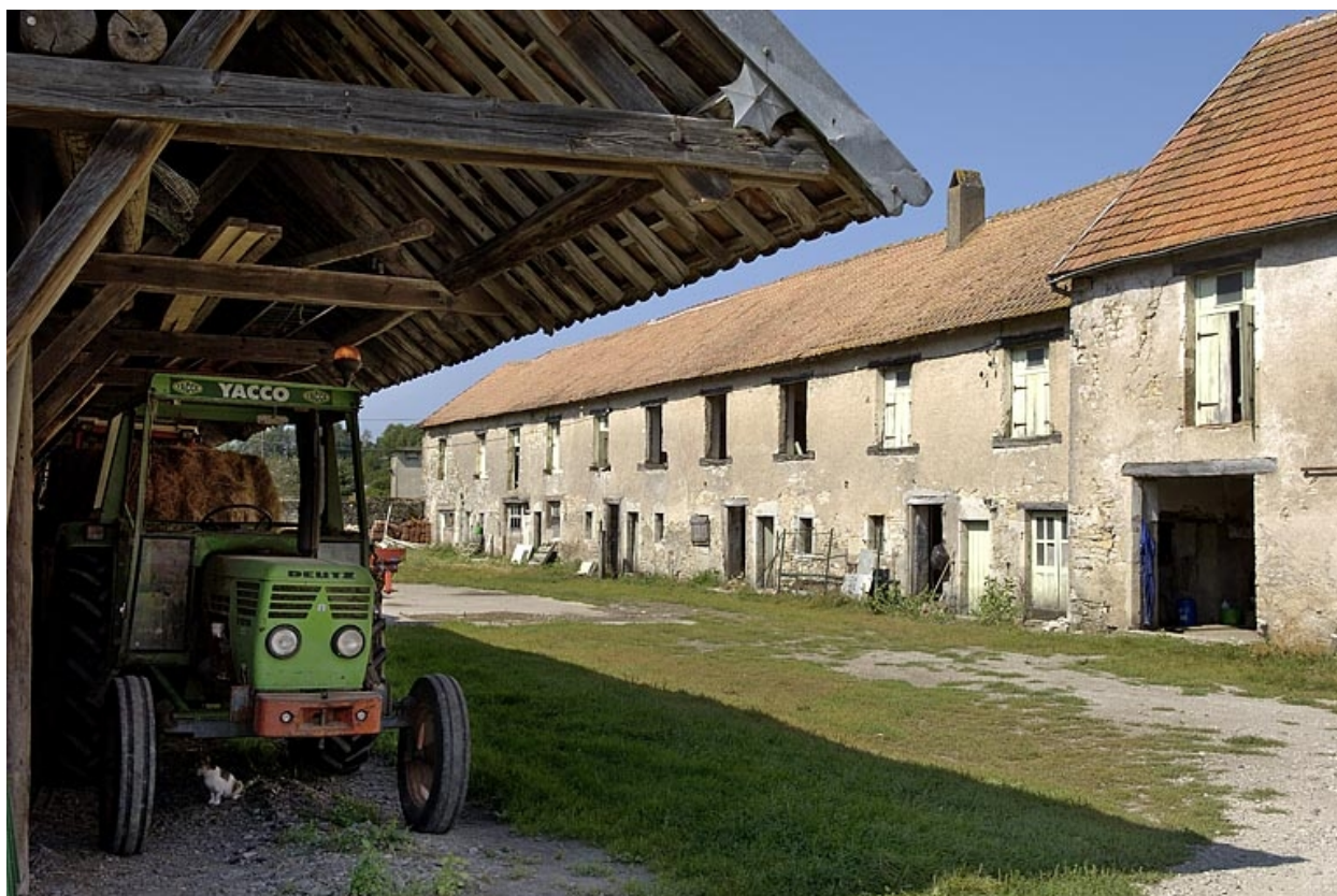
Aile ouest des logements ouvriers.
