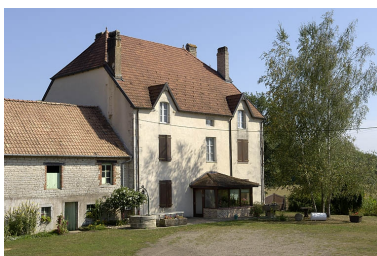
Ancien logement patronal. Phot. Jérôme Mongreville IVR43_20057000460NUCA
