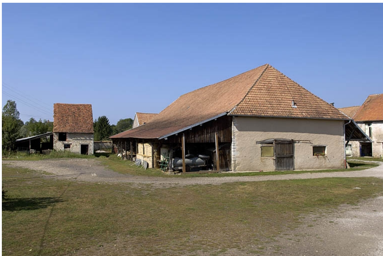
Vue depuis le sud-ouest de la cour.
