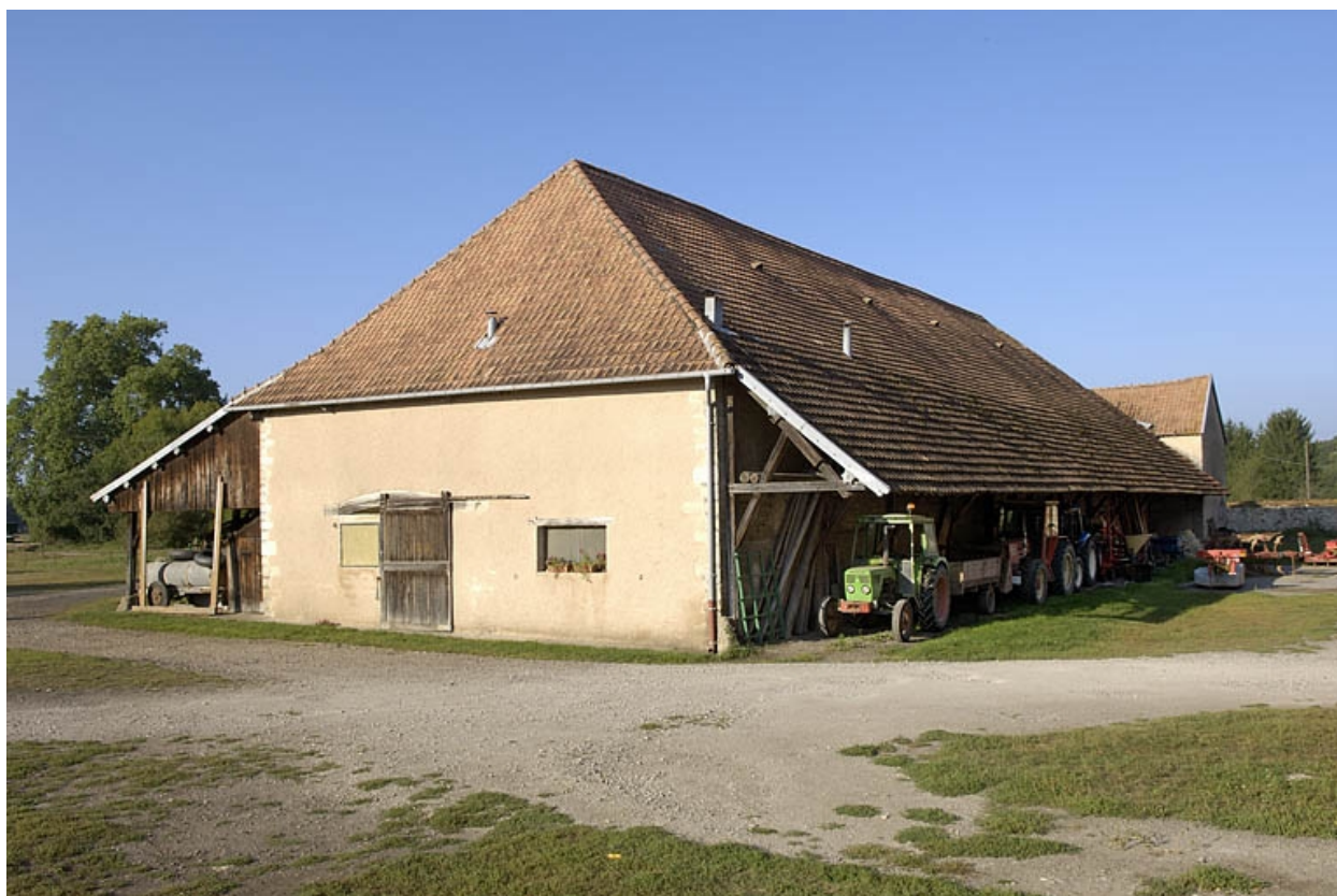
Halle à charbon vue de trois quarts.
