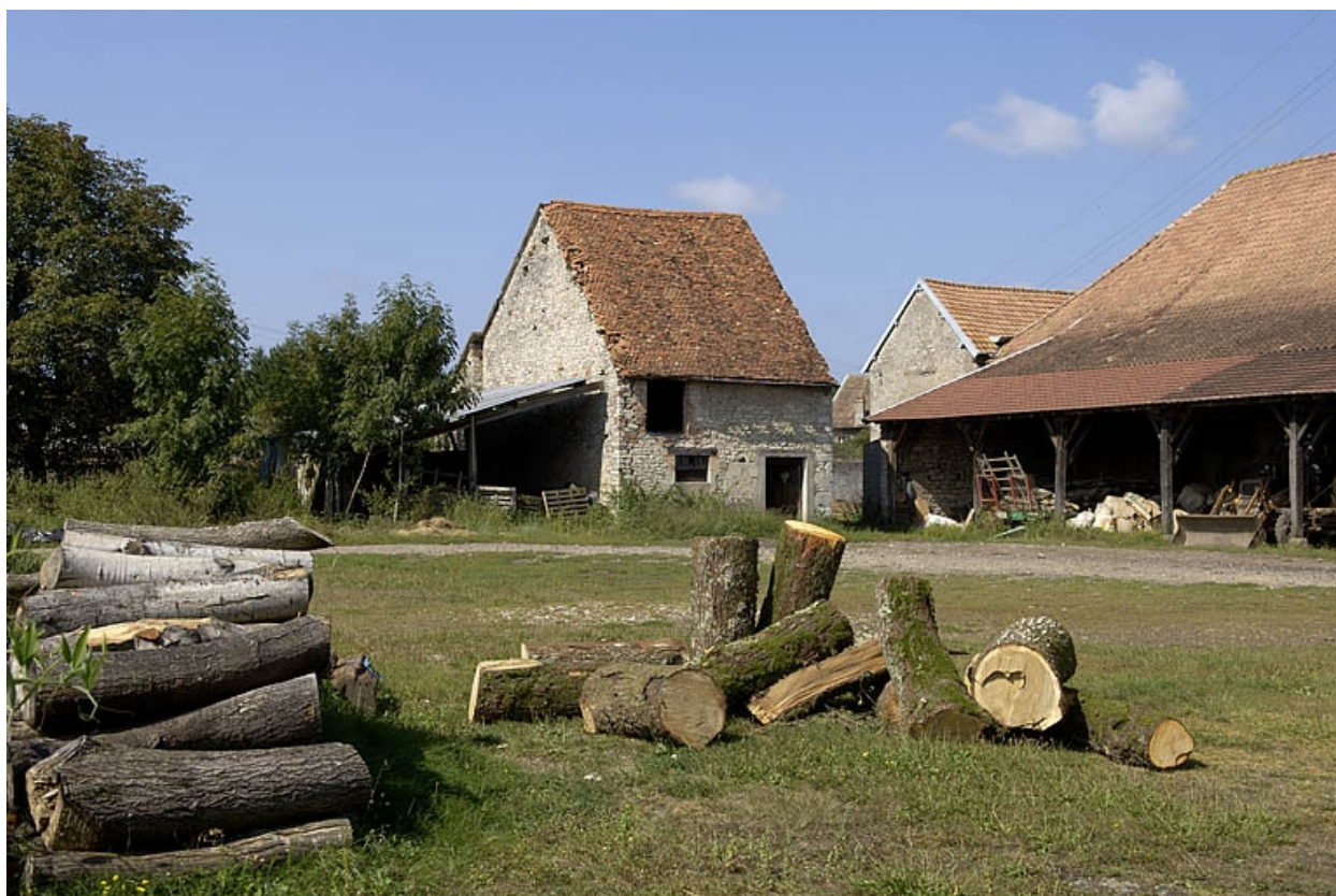
Bâtiments situés à l'ouest de la cour.
