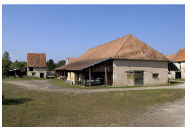
Vue depuis le sud-ouest de la cour. Phot. Jérôme Mongreville IVR43_20057000447NUCA
