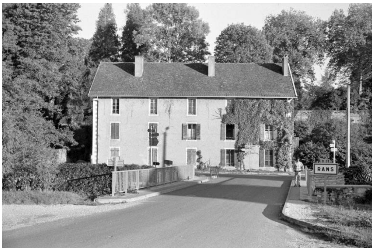
Façade antérieure du logement d'ouvriers (J).
