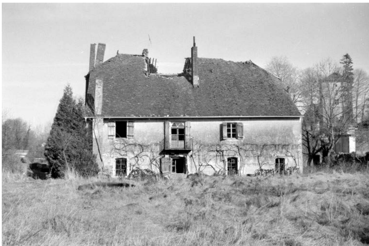
Façade postérieure du logement patronal.
