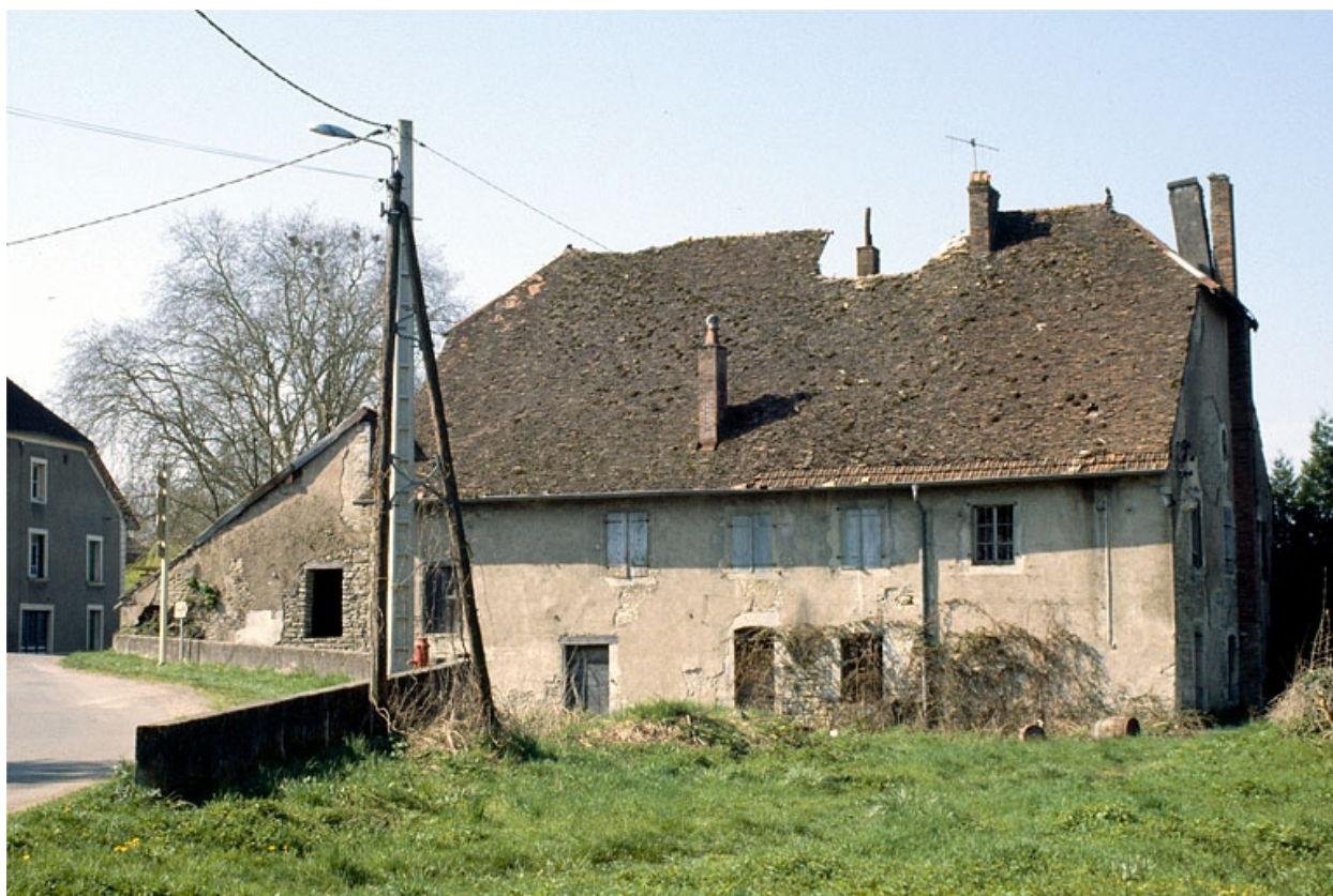
Façade antérieure du logement patronal (I).
