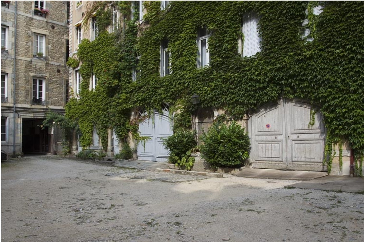
Premier logis secondaire, rez-de-chaussée : détail des remises.
