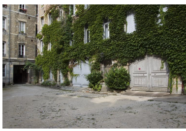
Premier logis secondaire, rez-de-chaussée : détail des remises.
