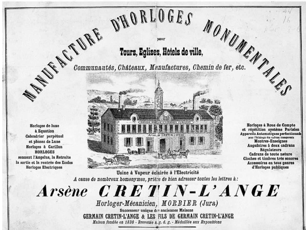
Façade antérieure de l'usine Cretin-l'Ange.
