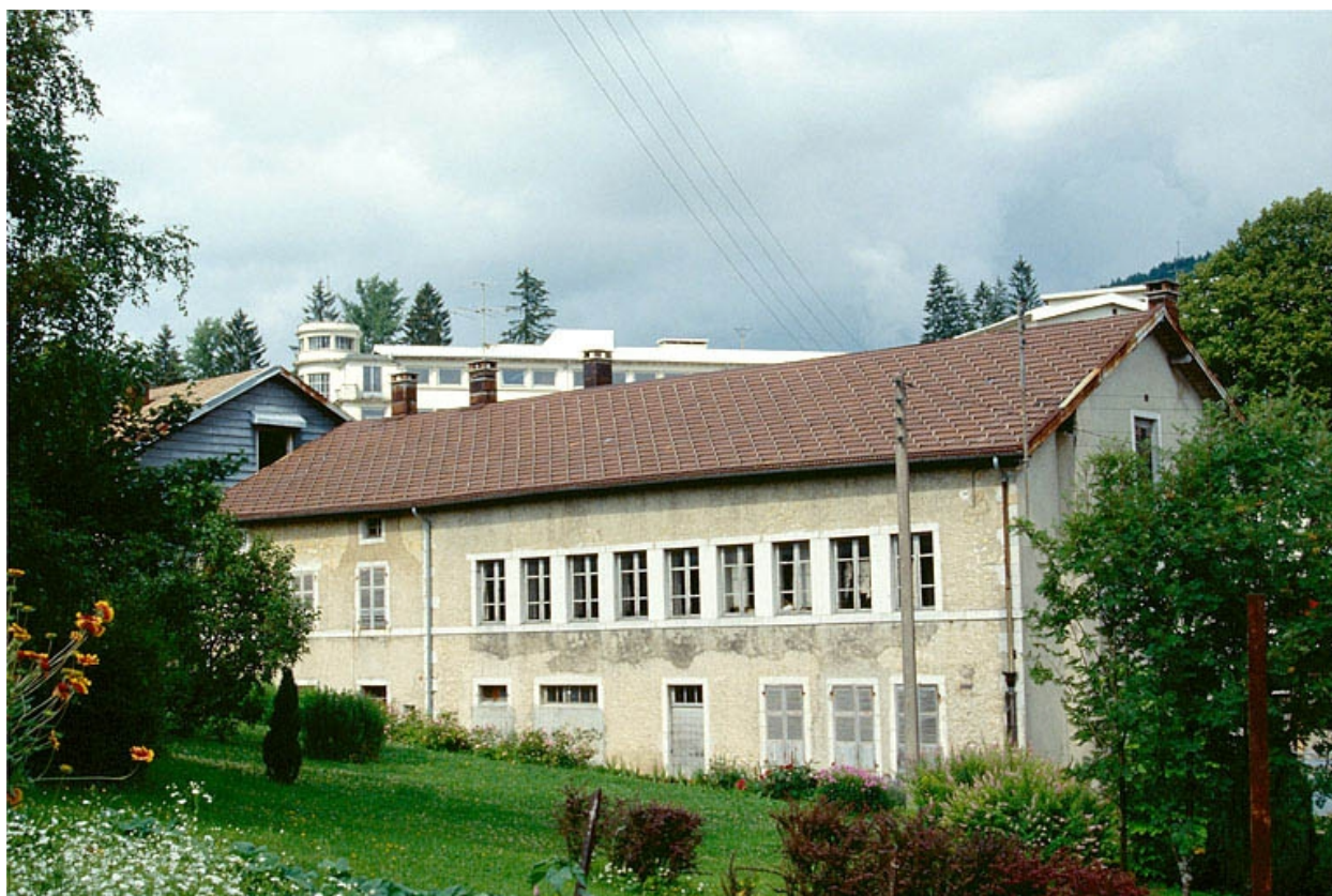
Vue d'ensemble de la façade postérieure.
