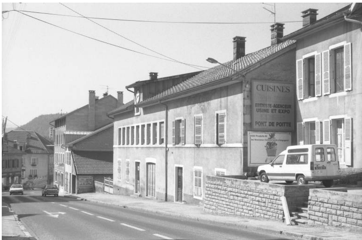
Vue d'ensemble de la façade antérieure.
