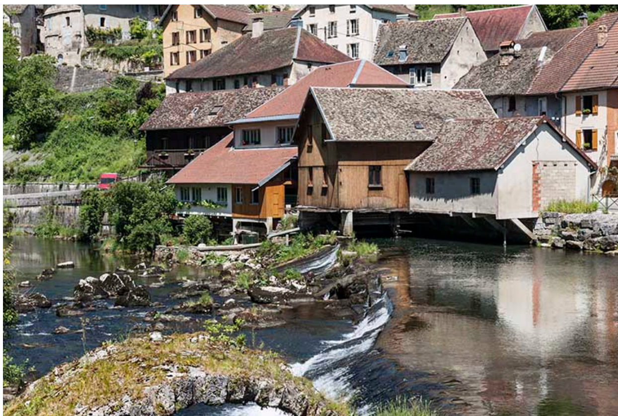
Vue depuis la tête amont du barrage.
