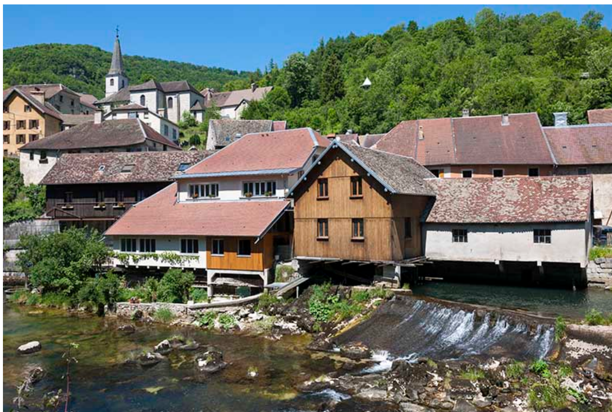
Vue rapprochée, depuis le sud-est.
