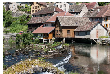
Vue depuis la tête amont du barrage. Phot. Jérôme Mongreville IVR43_20152501496NUC4A
