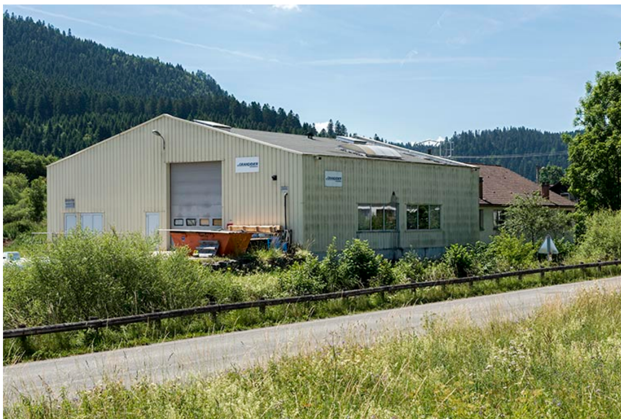
Façades postérieure et latérale droite.
