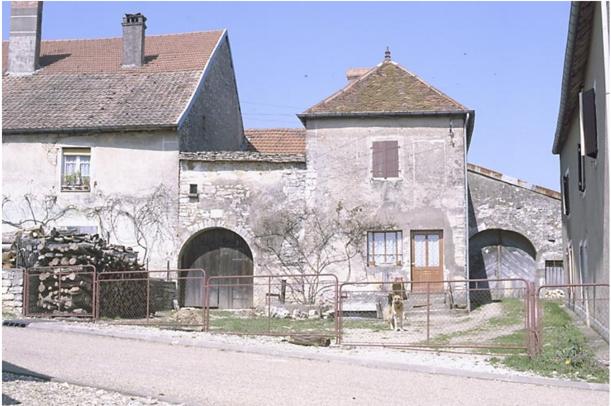
Façade antérieure sur cour en 1985.
