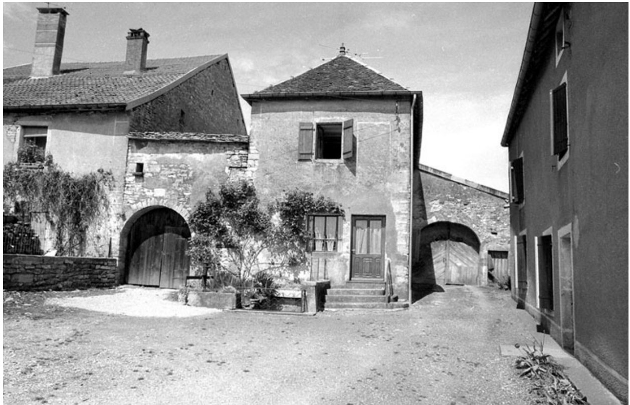
Façade antérieure sur cour en 1981.
