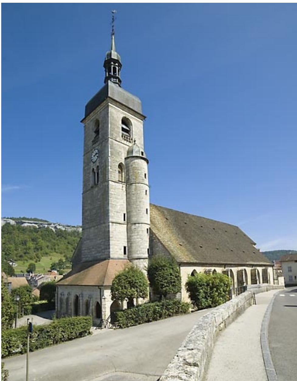
Vue de la tour clocher.
