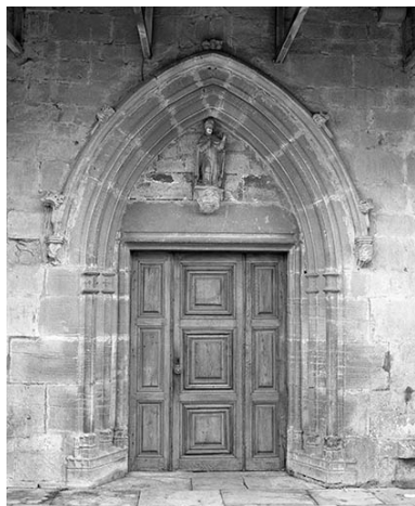
Face latérale gauche : porte. Phot. Dominique Humbert IVR43_19762501165X
