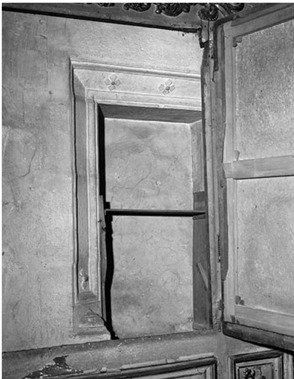
Intérieur, détail : niche du choeur.
