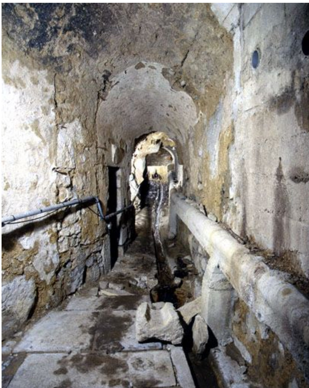
Conduit hydraulique des infirmeries vu depuis l'entrée.
