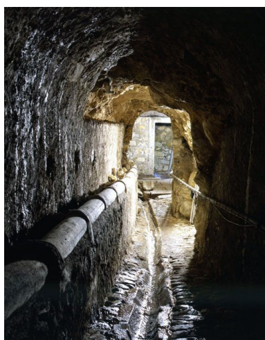
Conduit hydraulique des infirmeries vu depuis la source. Phot. Yves Sancey IVR43_20013900205XA
