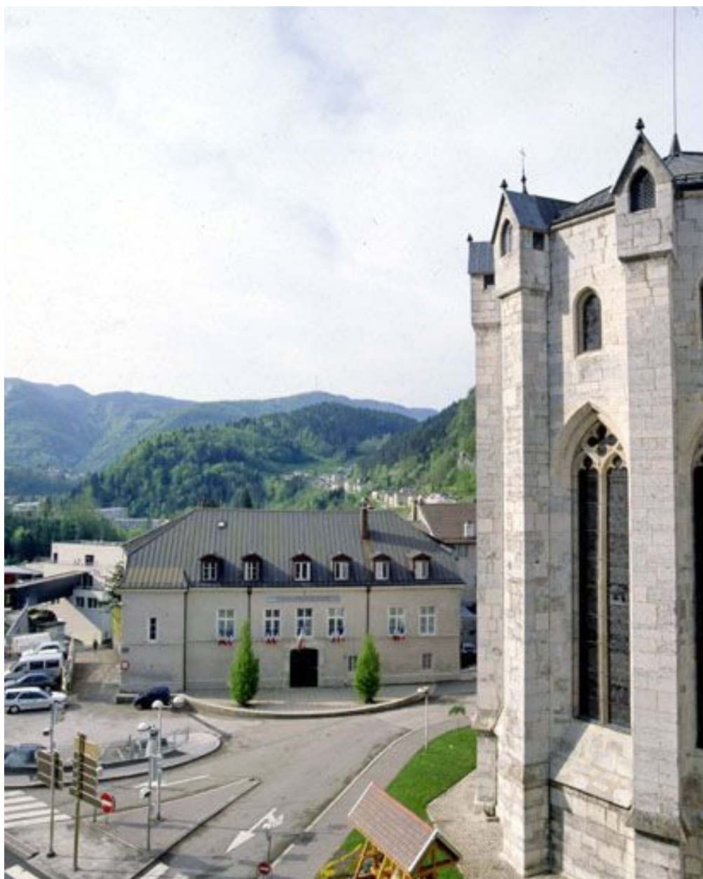
Façade sur rue vue depuis la cathédrale.
