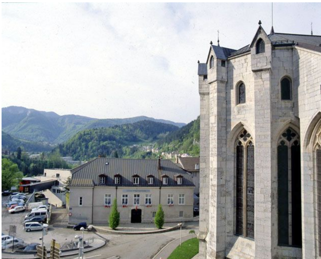
Façade sur rue vue depuis la cathédrale.
