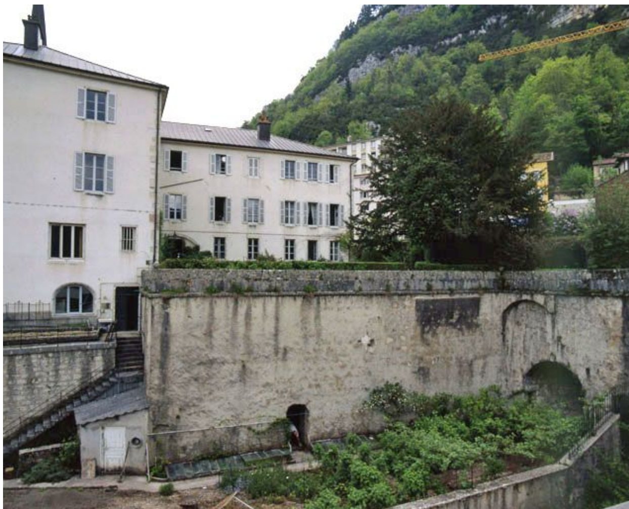
Partie droite des façades postérieures.
