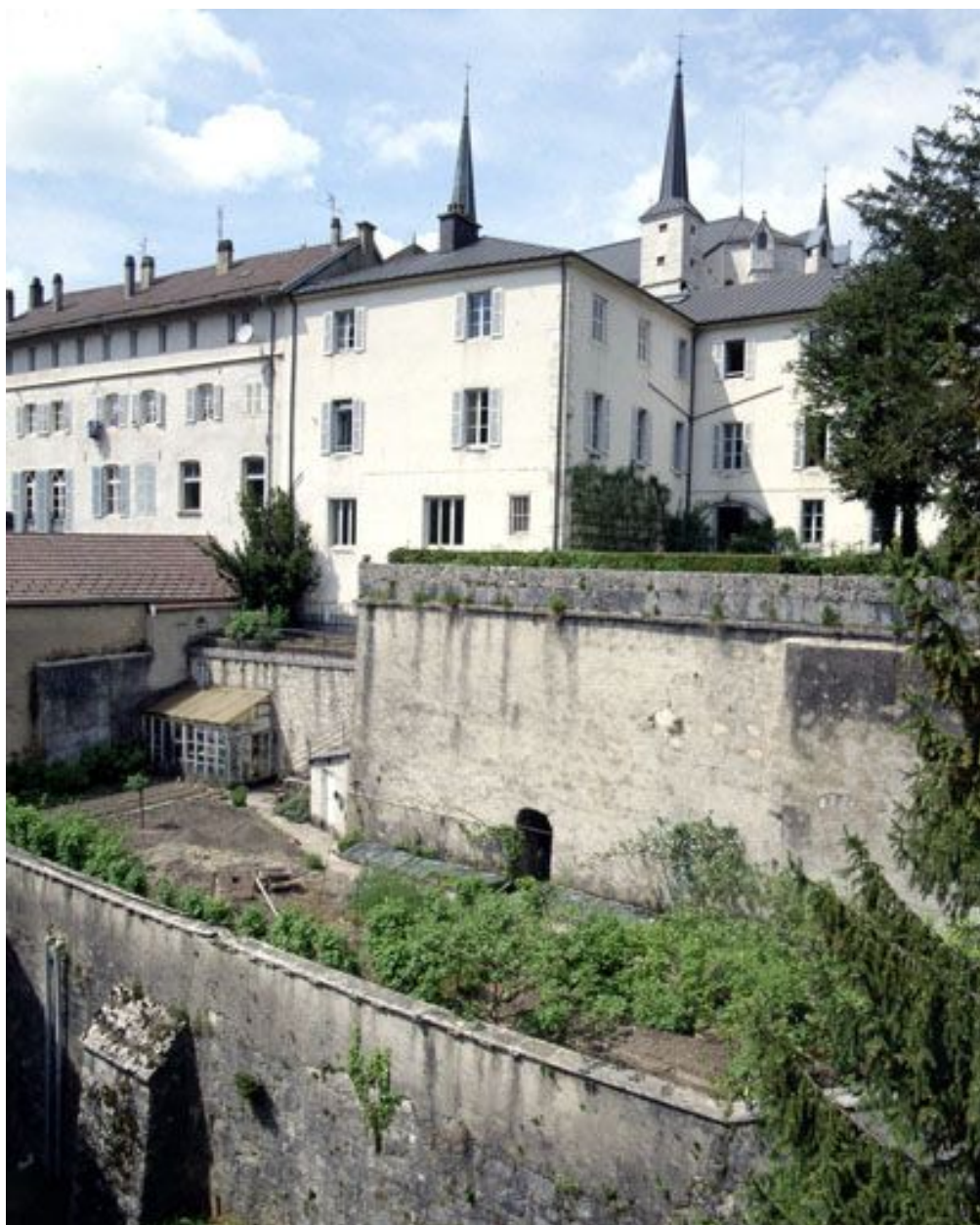
Vue générale des façades postérieures.
