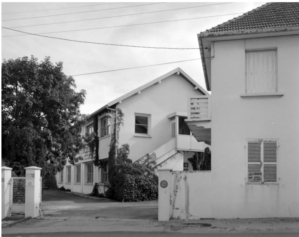
Entrée de l'usine, bureau et réfectoire.
