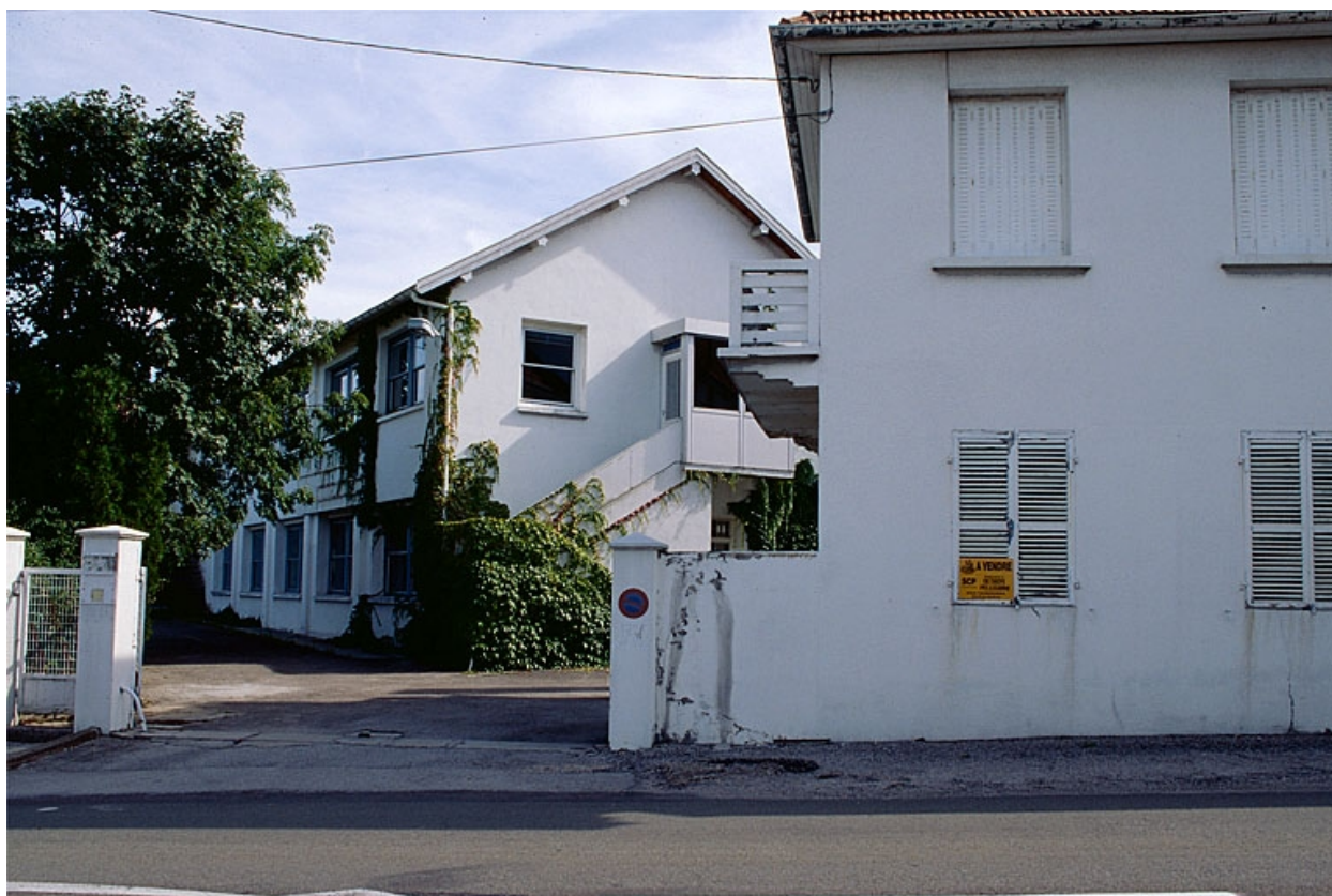
Réfectoire, bureau et logement rue Progin.
