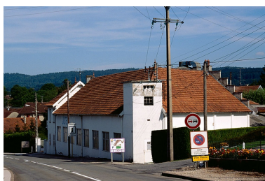
Atelier de fabrication rue Progin. Phot. Yves Sancey IVR43_19973901296ZA
