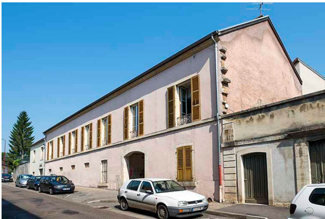
Angle sud-est de la cantine, 4 rue Rossen.
