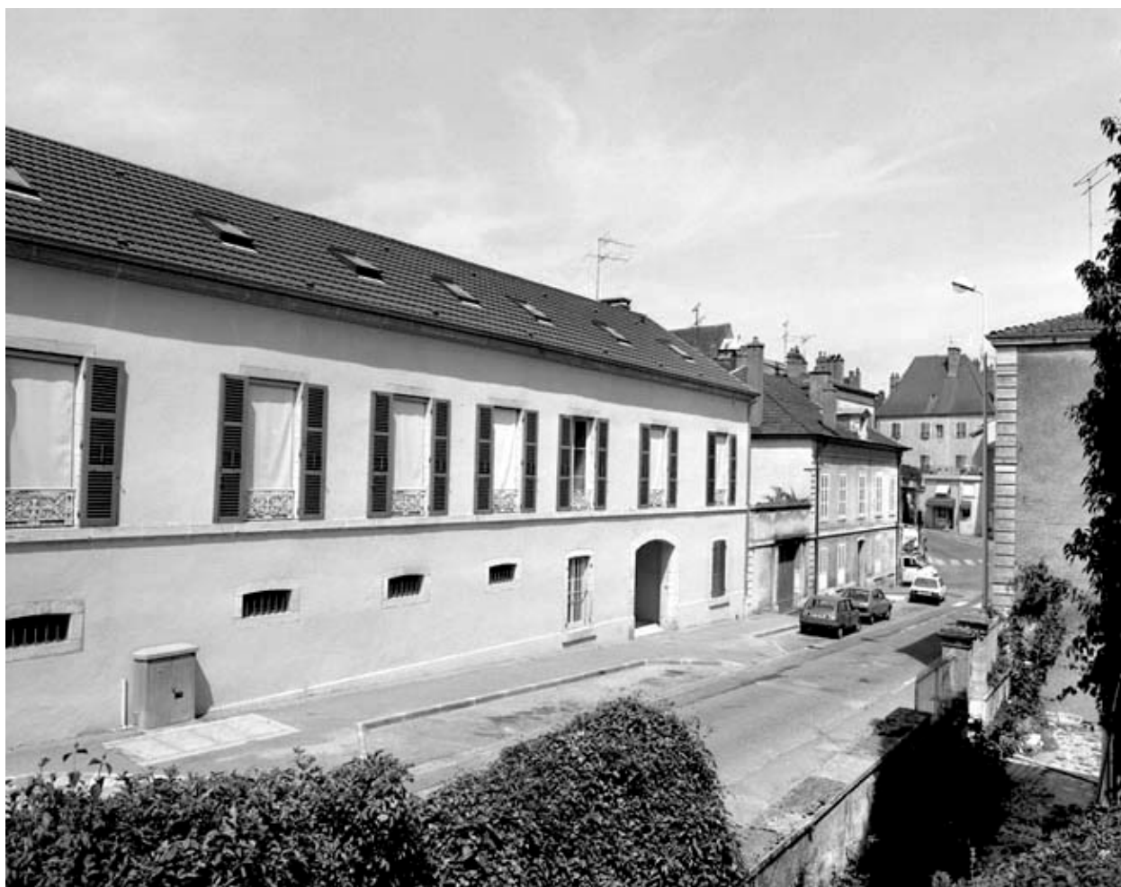
Façade antérieure de trois quarts gauche en 1989.
