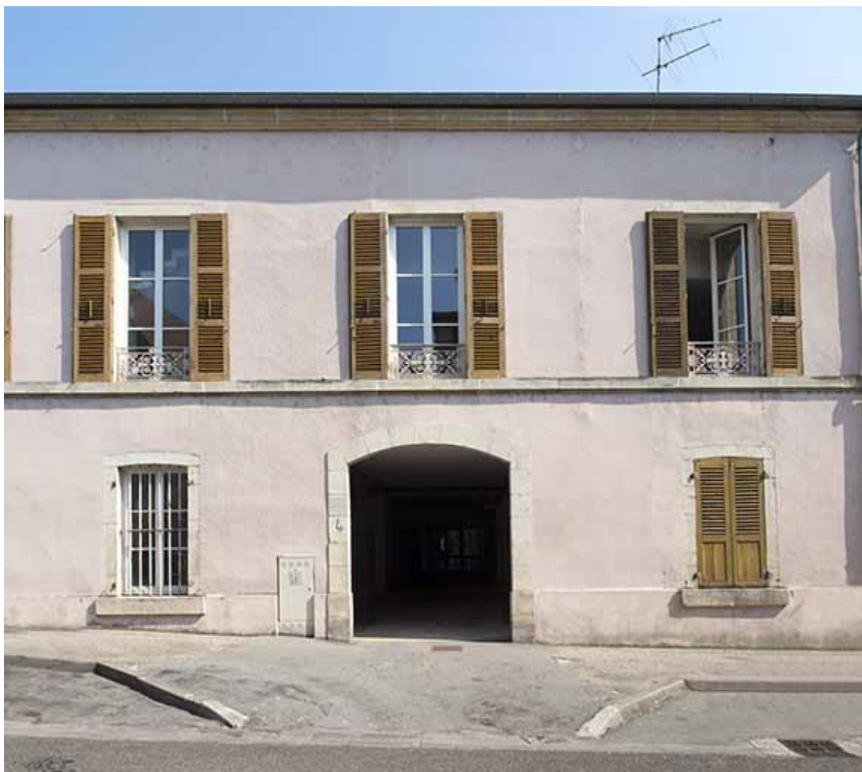
Entrée de la cantine 4 rue Rossen.
