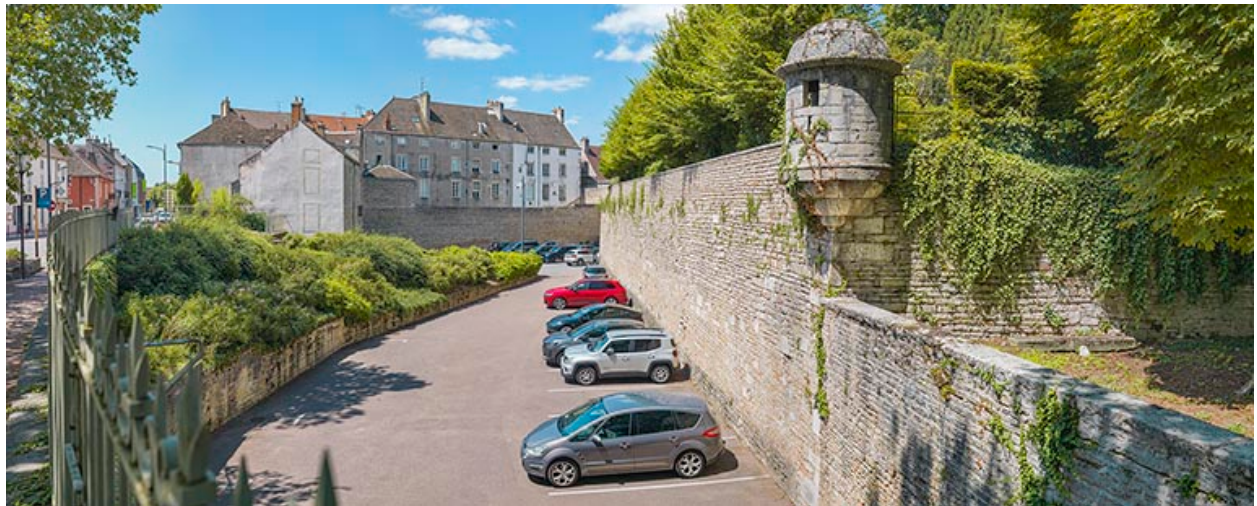
Vue d'une face du bastion.
