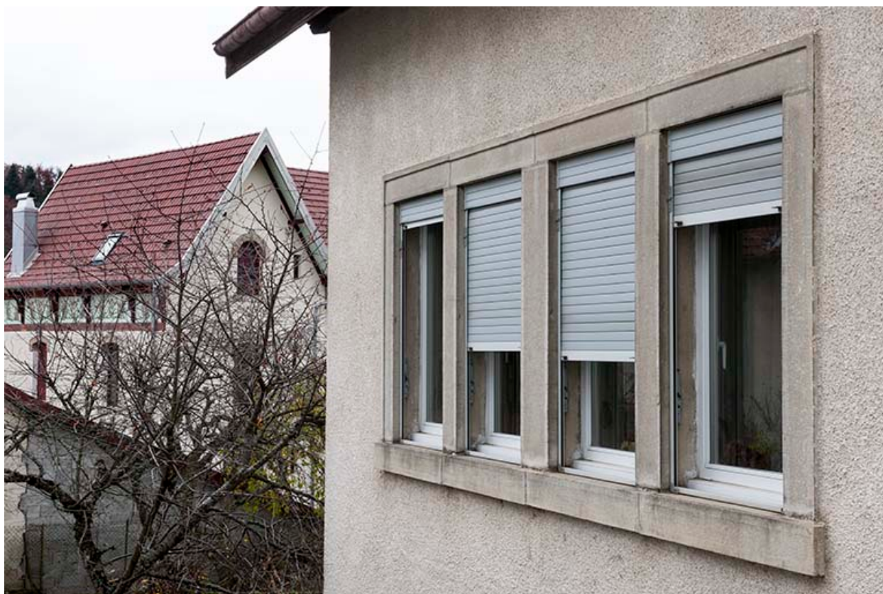
Façade latérale gauche : fenêtres multiples.
