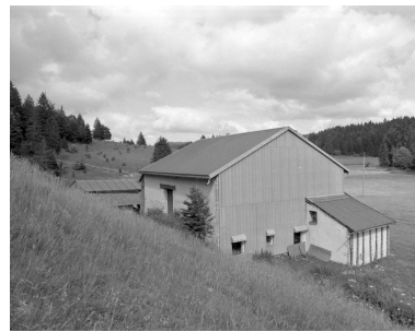
Face gauche recouverte d'un essentage de tôle et façade postérieure. Phot. Jérôme Mongreville IVR43_19943900745X
