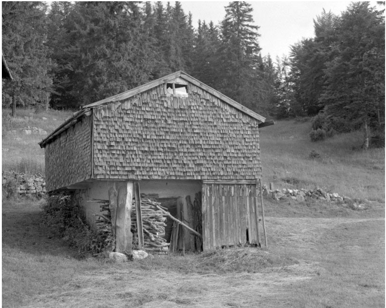
La resserre avec un accès en soubassement.
