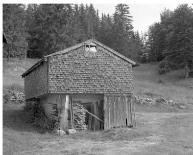
La resserre avec un accès en soubassement. Phot. Jérôme Mongreville IVR43_19943900743X
