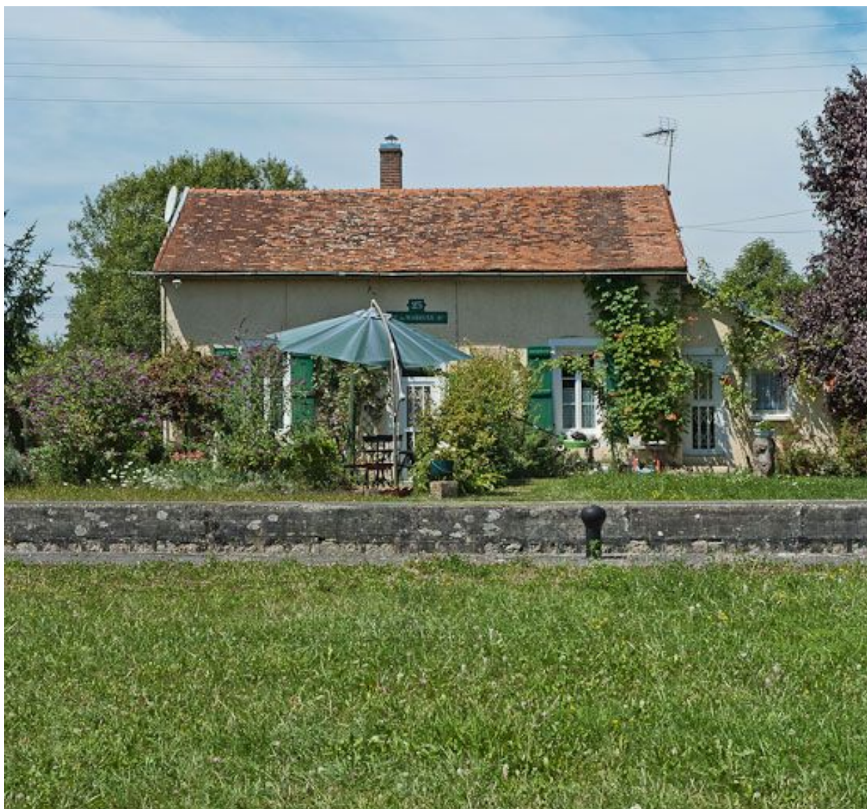
Vue de face de la maison éclusière.
