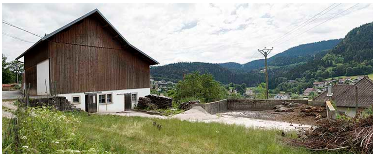
Façade postérieure de l'étable.
