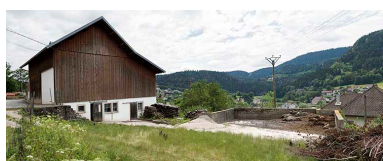
Façade postérieure de l'étable. Phot. Sonia Dourlot IVR43_20162500865NUC4A
