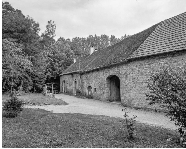
Façade sur cour. Phot. Yves Sancey IVR43_19843900103X
