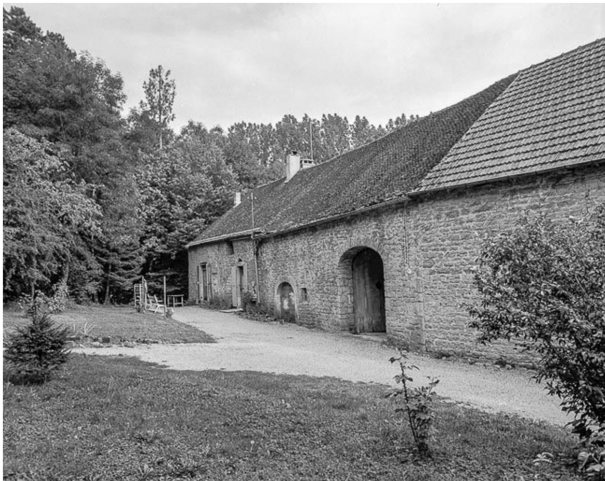
Façade sur cour.
