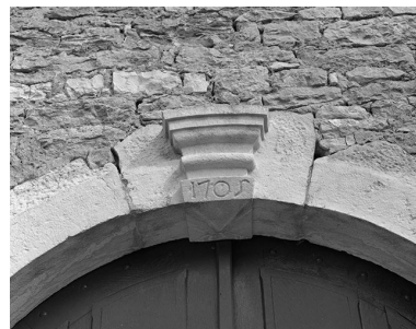
Clef de l'arc du portail. Phot. Yves Sancey IVR43_19843900176X
