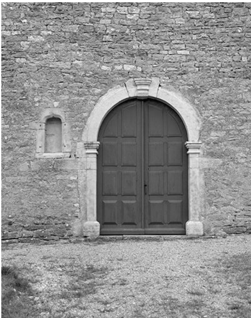
Portail de la façade antérieure.
