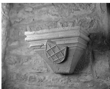
Intérieur : chapelle, mur est, console gauche. Phot. Yves Sancey IVR43_19843900184X
