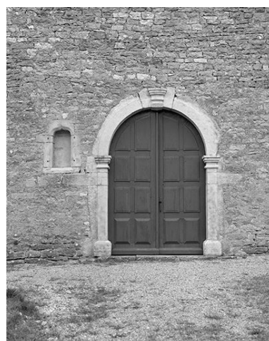
Portail de la façade antérieure. Phot. Yves Sancey IVR43_19843900175X
