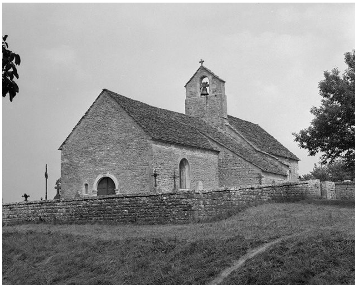
Façade antérieure et face droite.
