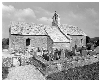
Façade droite. Phot. Jérôme Mongreville IVR43_19953900540X
