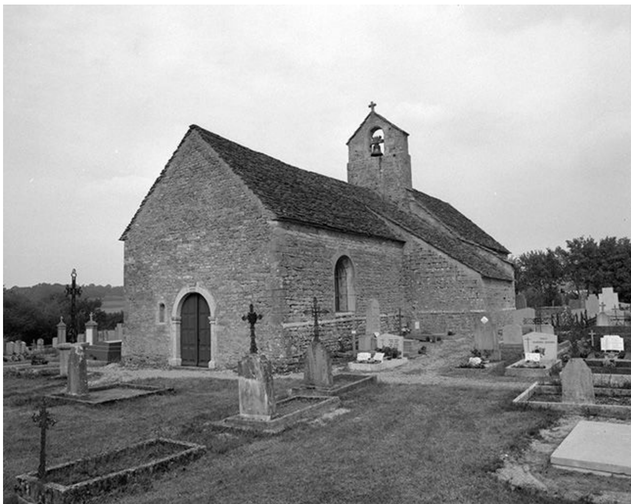
Façade antérieure et face droite.
