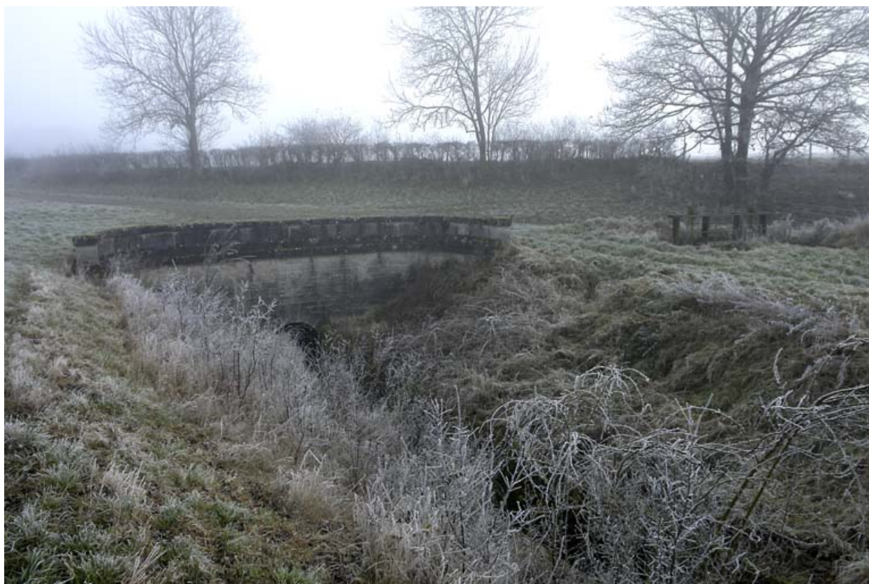
Sortie de l'aqueduc.
