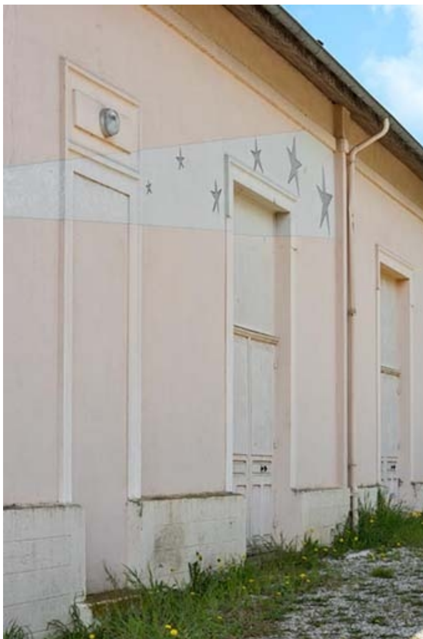
Façade antérieure : décor peint, vu en enfilade.
