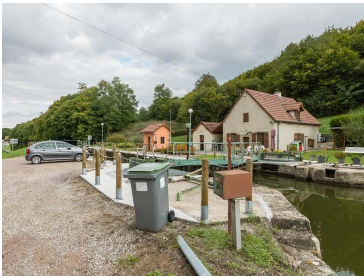
Vue d'ensemble du site d'écluse.
