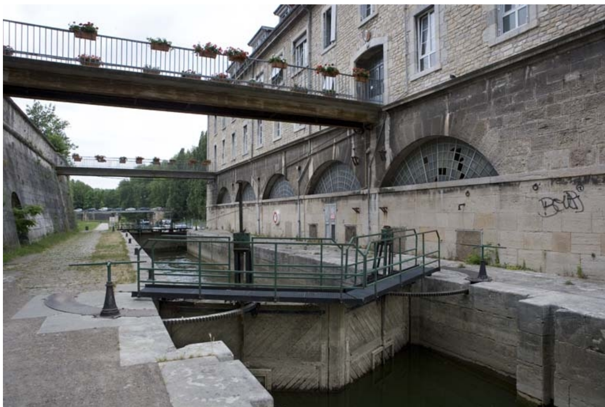
Vue d'ensemble depuis l'amont, côté gauche.
