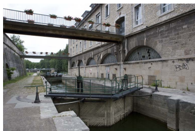
Vue d'ensemble depuis l'amont, côté gauche. Phot. Yves Sancey IVR43_20062500306NUCA
