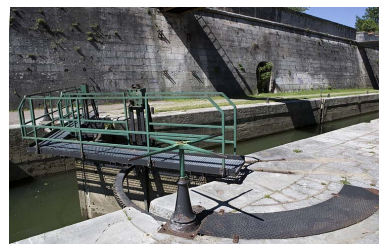
Porte amont droite, tourniquet et crémaillère. Phot. Yves Sancey IVR43_20062500177NUCA
