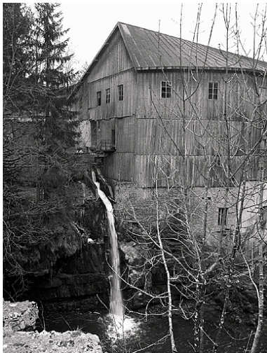
Extrémité est de l'atelier de fabrication. Phot. Yves Sancey IVR43_19983900043X
