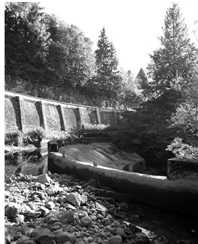
Bassin de retenue (à sec) et barrage. Phot. Yves Sancey IVR43_19973901159X
