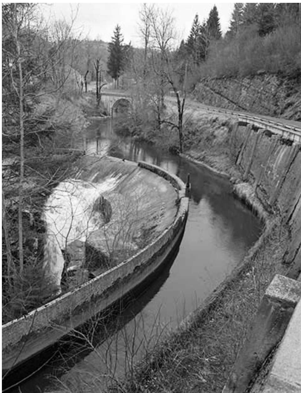
Canal d'amenée de la centrale.
