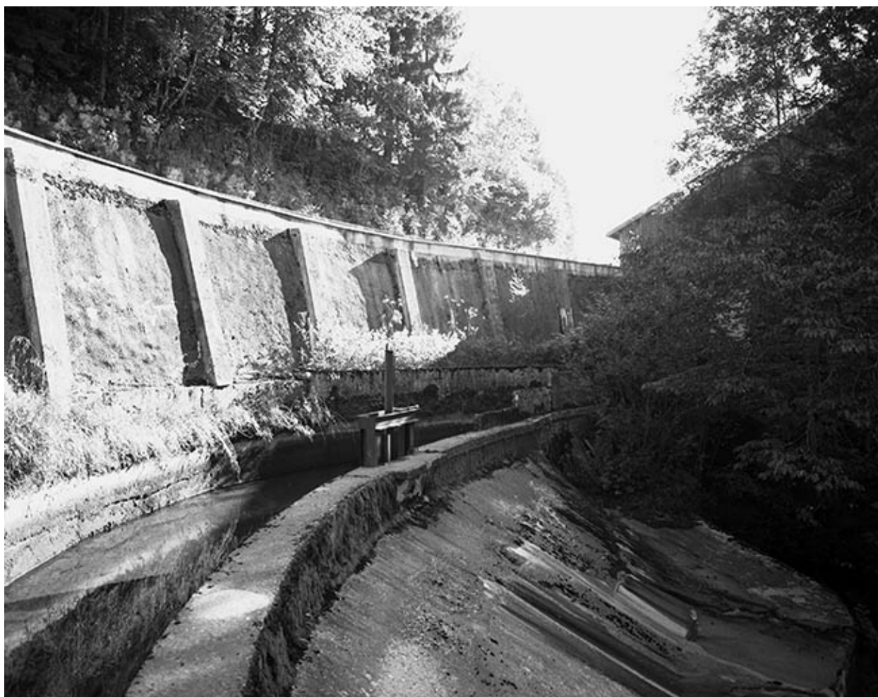
Canal d'amenée et déversoir du barrage.
