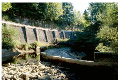
Canal d'amenée et déversoir du barrage. Phot. Yves Sancey IVR43_19973901158ZA
