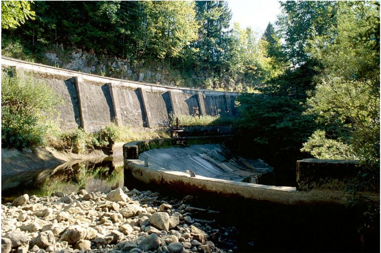
Canal d'amenée et déversoir du barrage.
