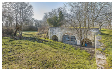
Débouché du passage couvert depuis les chambrées.
