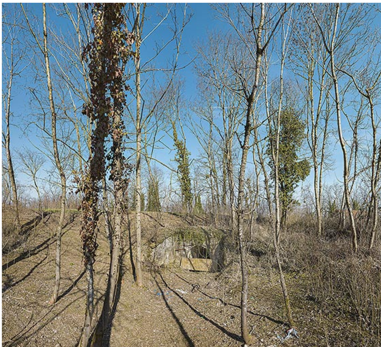
Traverse-abri envahie par la végétation.
