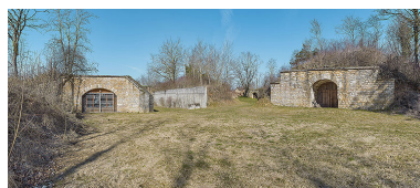
La rue des Remparts : sortie latérale du passage couvert (à gauche) et une traverse-abri (à droite).
