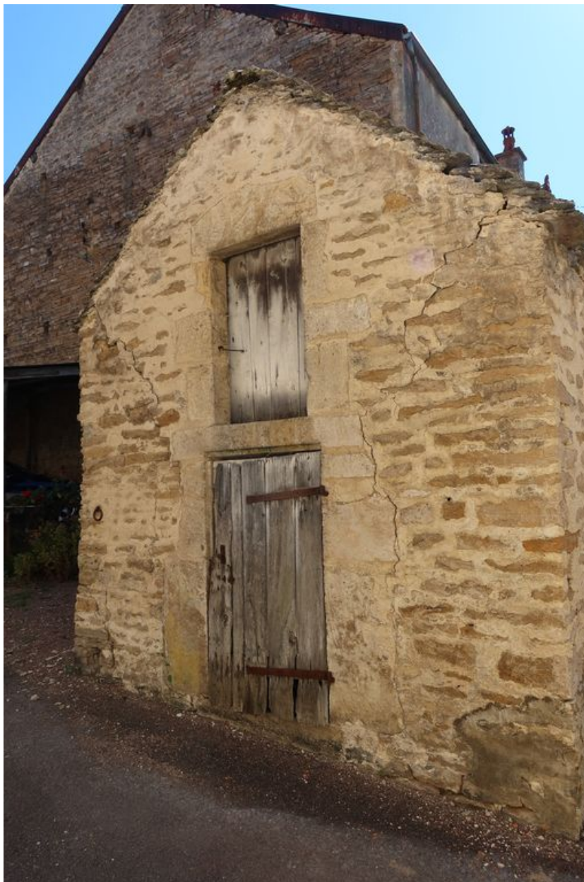
Détail de l'élévation ouest de la construction.
