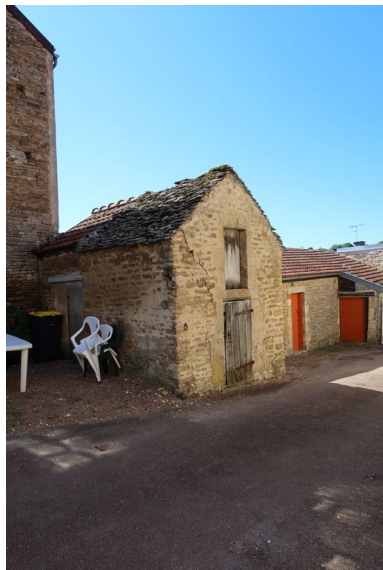
Vue du poulailler depuis le nord-ouest. Phot. Morgane Guillemain IVR26_20222101154NUC2A
