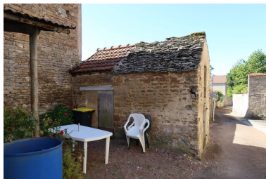
Détail de l'élévation nord de la construction. Phot. Morgane Guillemain IVR26_20222101155NUC2A
