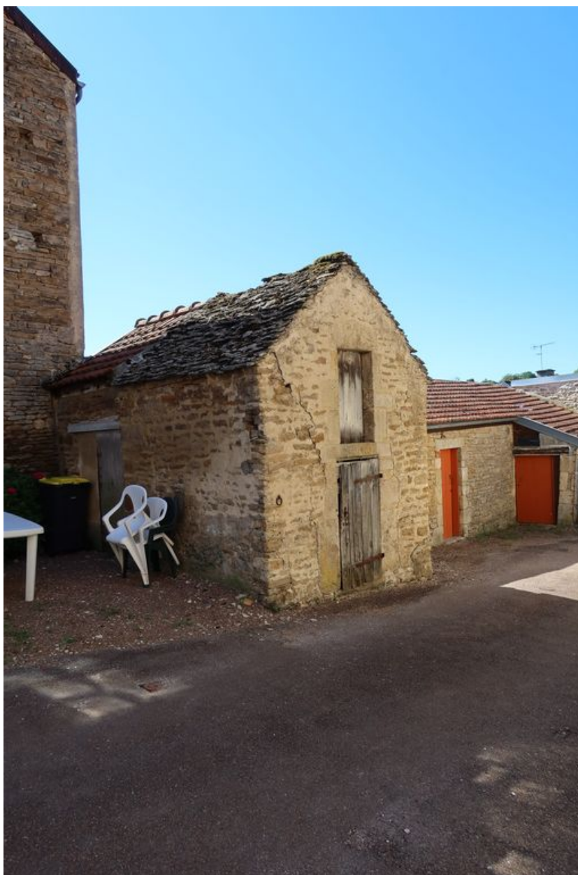
Vue du poulailler depuis le nord-ouest.
