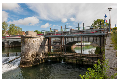
Vanne de décharge à l'extrémité nord du barrage. Phot. Jérôme Mongreville IVR43_20152501282NUC4A
