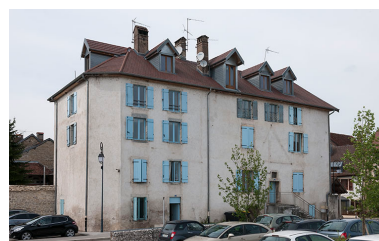
Logements d'ouvriers. Phot. Jérôme Mongreville IVR43_20152501280NUC4A
