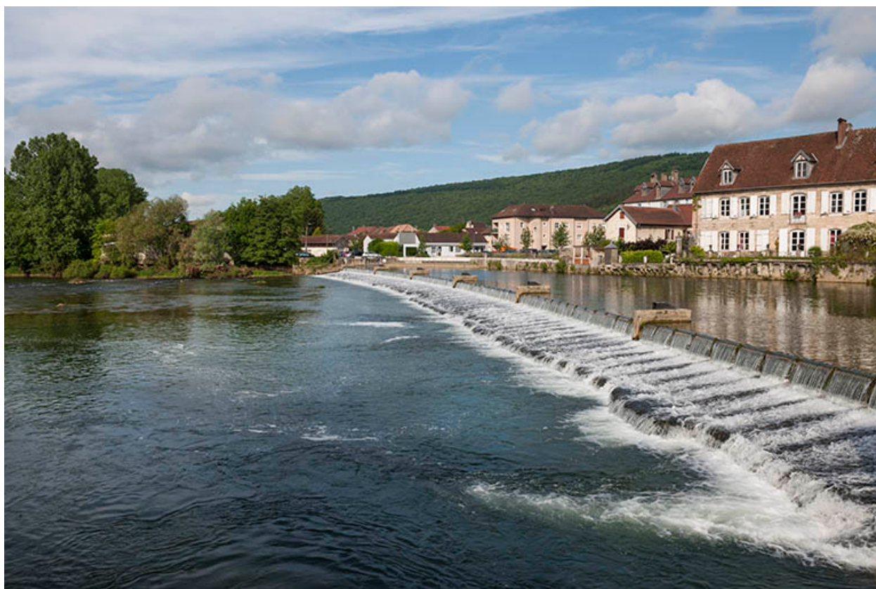
Vue du barrage depuis le pont.
