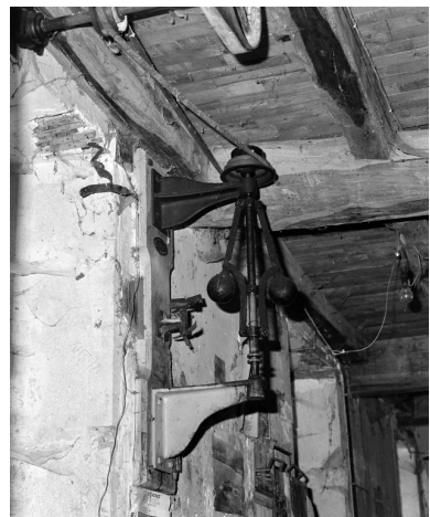
1er étage. Régulateur. Phot. Jean-Luc Duthu IVR26_20062106698X
