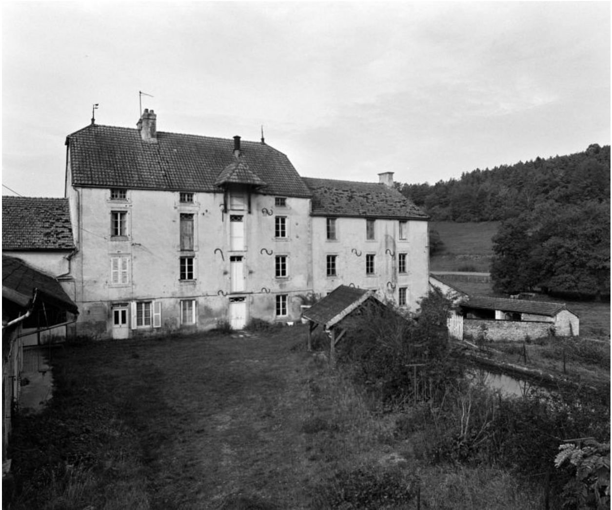
Les bâtiments principaux. Vue prise de l'est, depuis le portail d'entrée.
