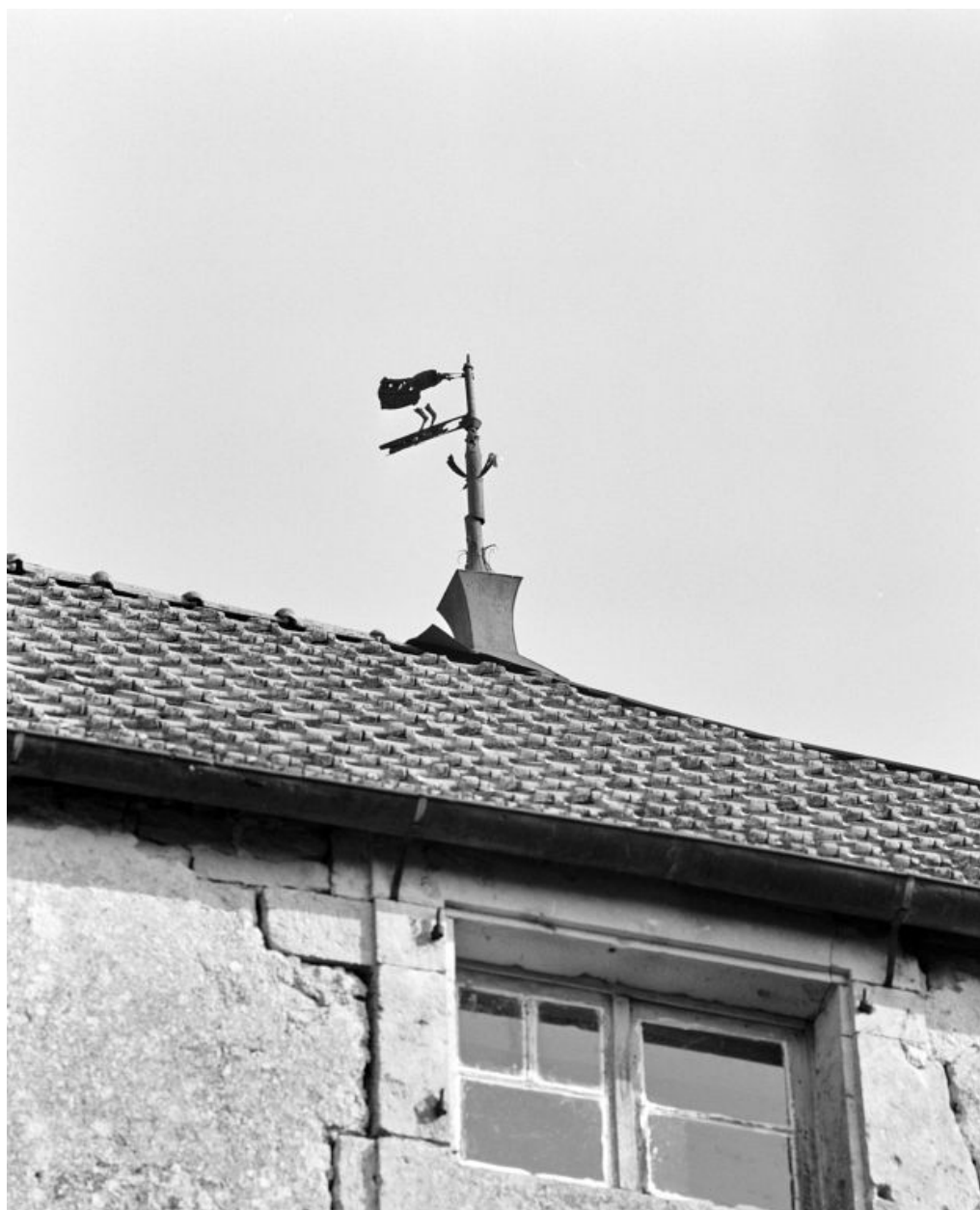
Girouette sur le faîtage du corps gauche.
