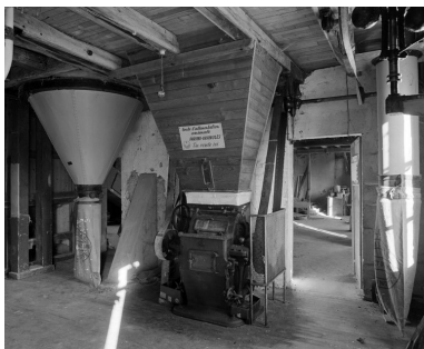
1er étage. Broyeur et ensacheur. Phot. Jean-Luc Duthu IVR26_20062106694X
