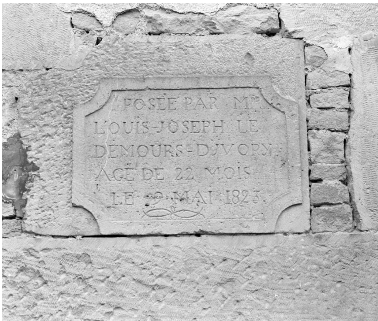
Plaque de fondation. Corps principal, façade antérieure.
