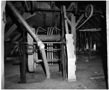
Comble à surcroît. Monte-sacs. Phot. Jean-Luc Duthu IVR26_20062106754X
