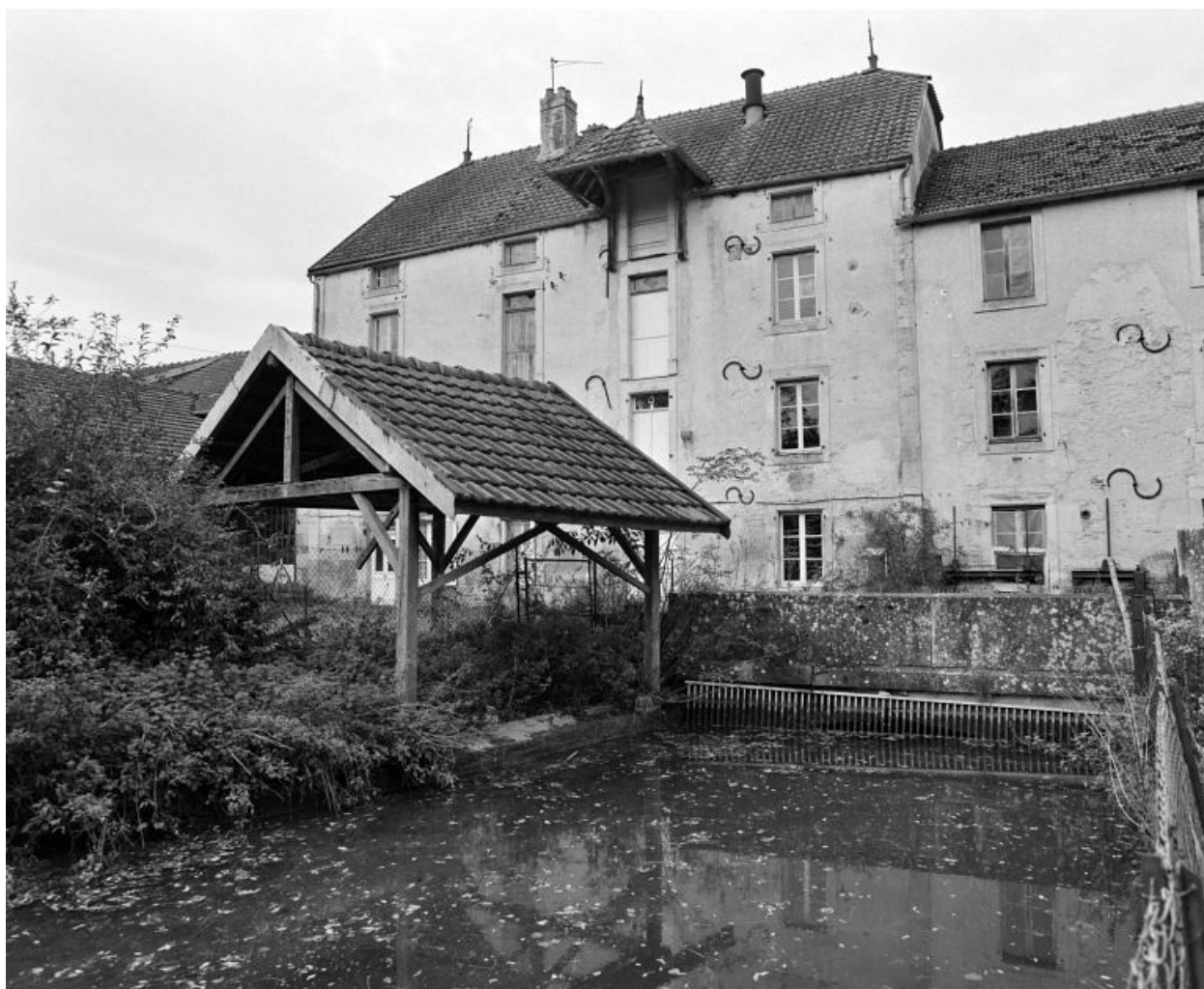
Les bâtiments principaux et le lavoir. Vue prise de l'est, depuis le bord de la Coquille.
