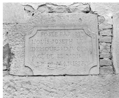
Plaque de fondation. Corps principal, façade antérieure. Phot. Jean-Luc Duthu IVR26_20062106601X
