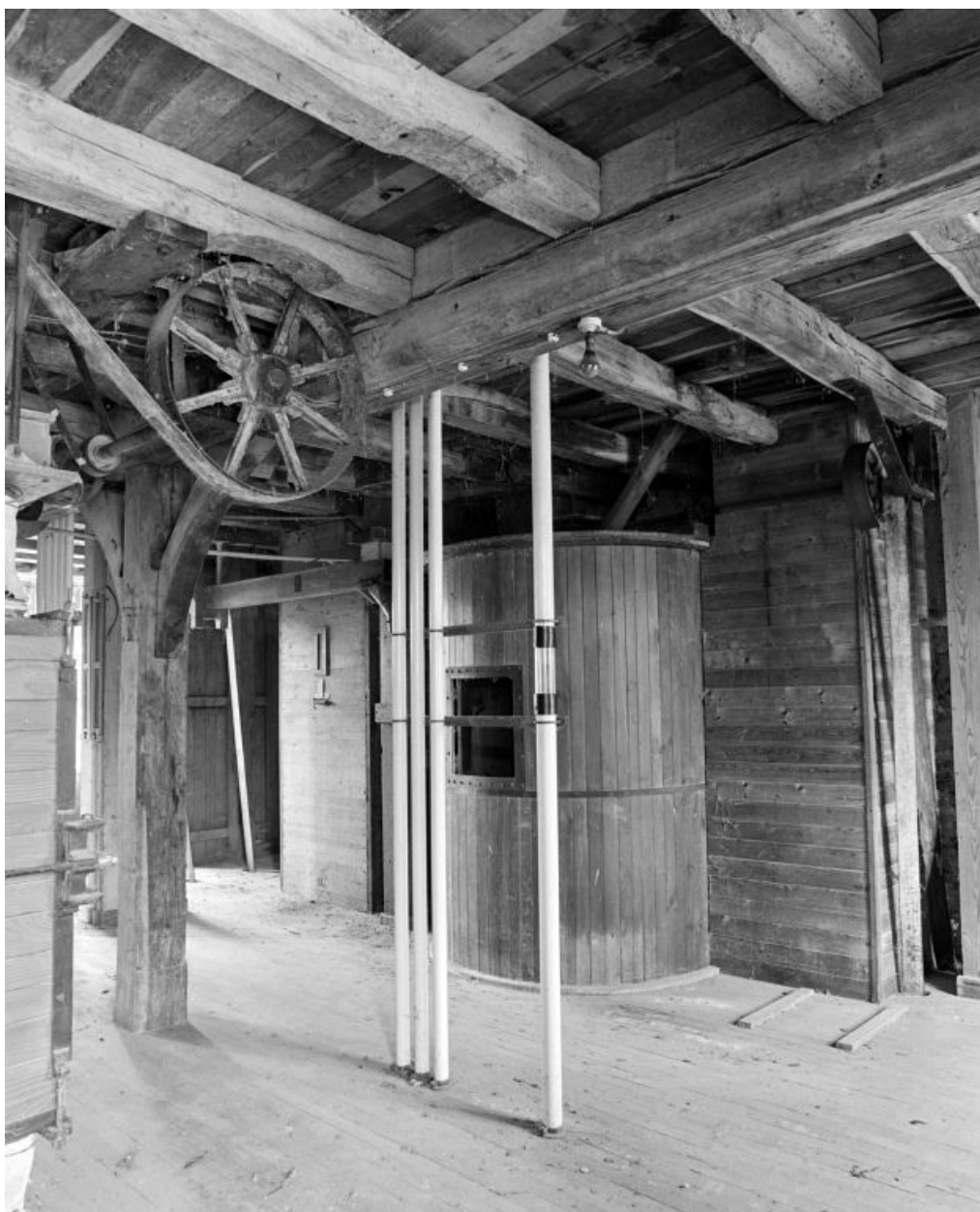
2e étage. Mélangeur.
