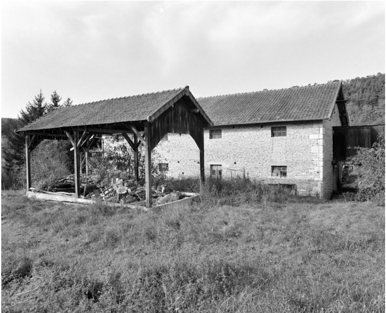
La porcherie et le hangar. Vue prise du sud.
