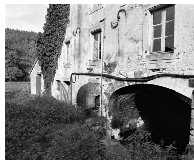
Le bâtiment droit. Elévation postérieure, détail. Phot. Jean-Luc Duthu IVR26_20062106624X
