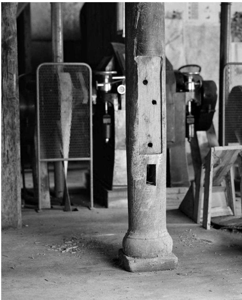
Rez-de-chaussée. Salle des machines, détail.
