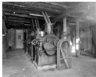
Rez-de-chaussée. Broyeurs. Phot. Jean-Luc Duthu IVR26_20062106644X
