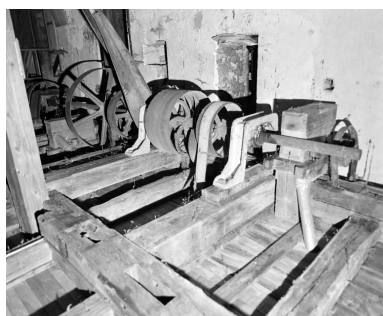
Rez-de-chaussée. Arbre de transmission et poulies. Phot. Jean-Luc Duthu IVR26_20062106666X
