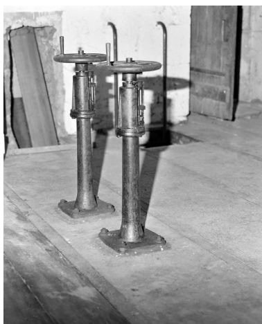
Rez-de-chaussée. Commandes d'ouverture des vannes. Phot. Jean-Luc Duthu IVR26_20062106673X
