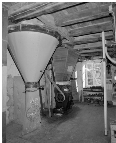
1er étage. Broyeur et ensacheur. Phot. Jean-Luc Duthu IVR26_20062106696X
