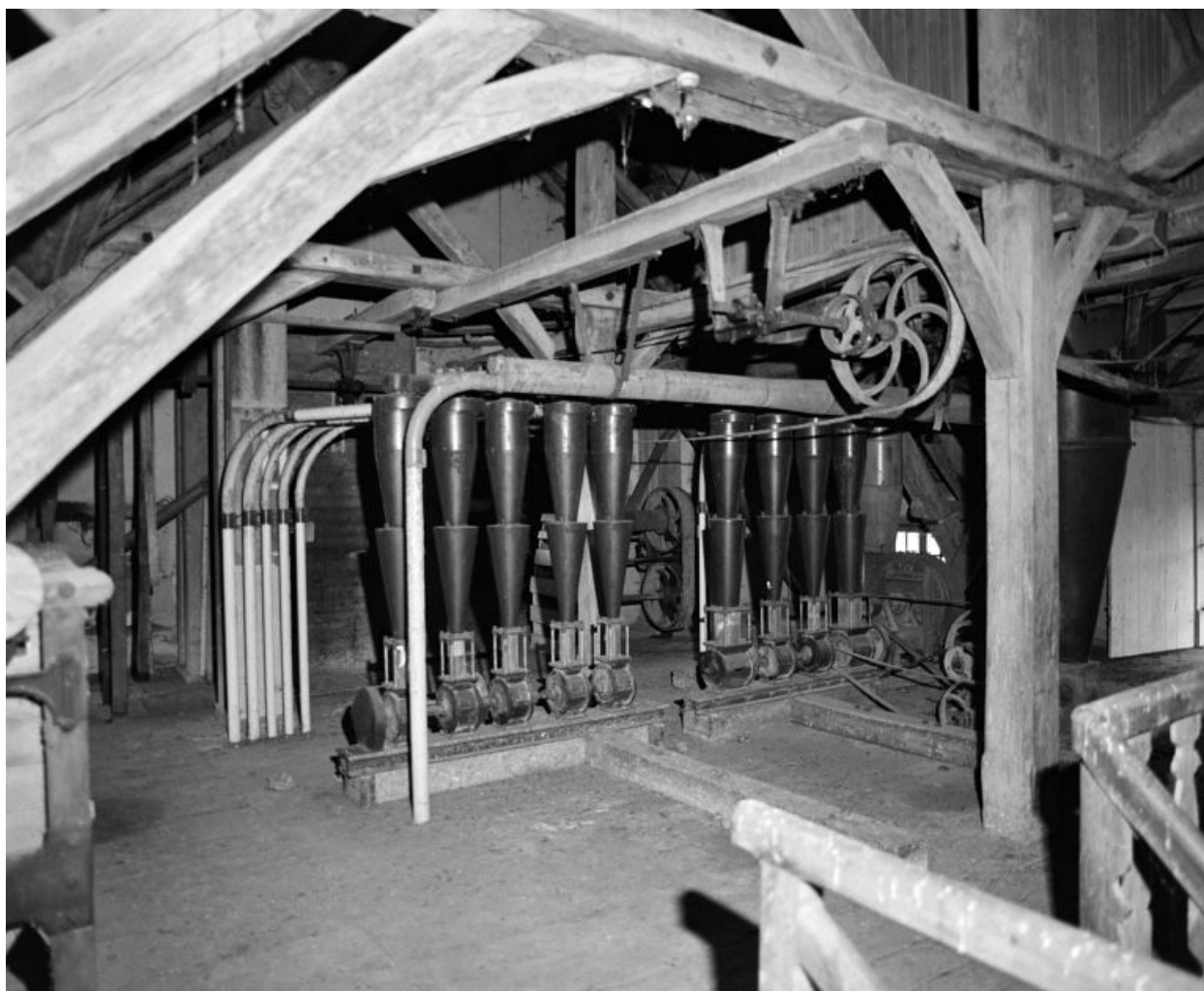
Comble à surcroît. Ecluses.
