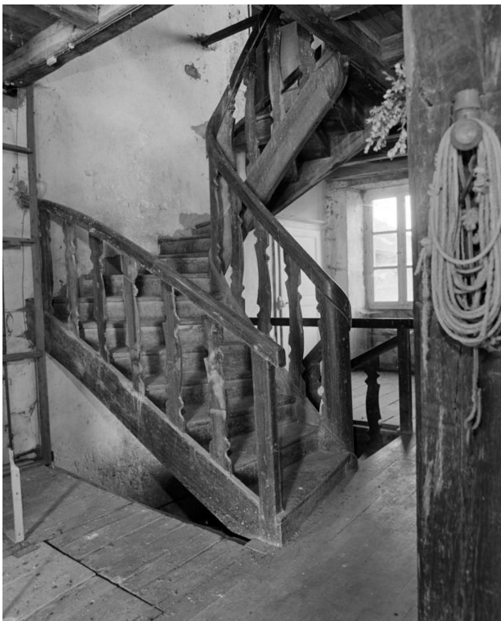
1er étage. Escalier, détail.
