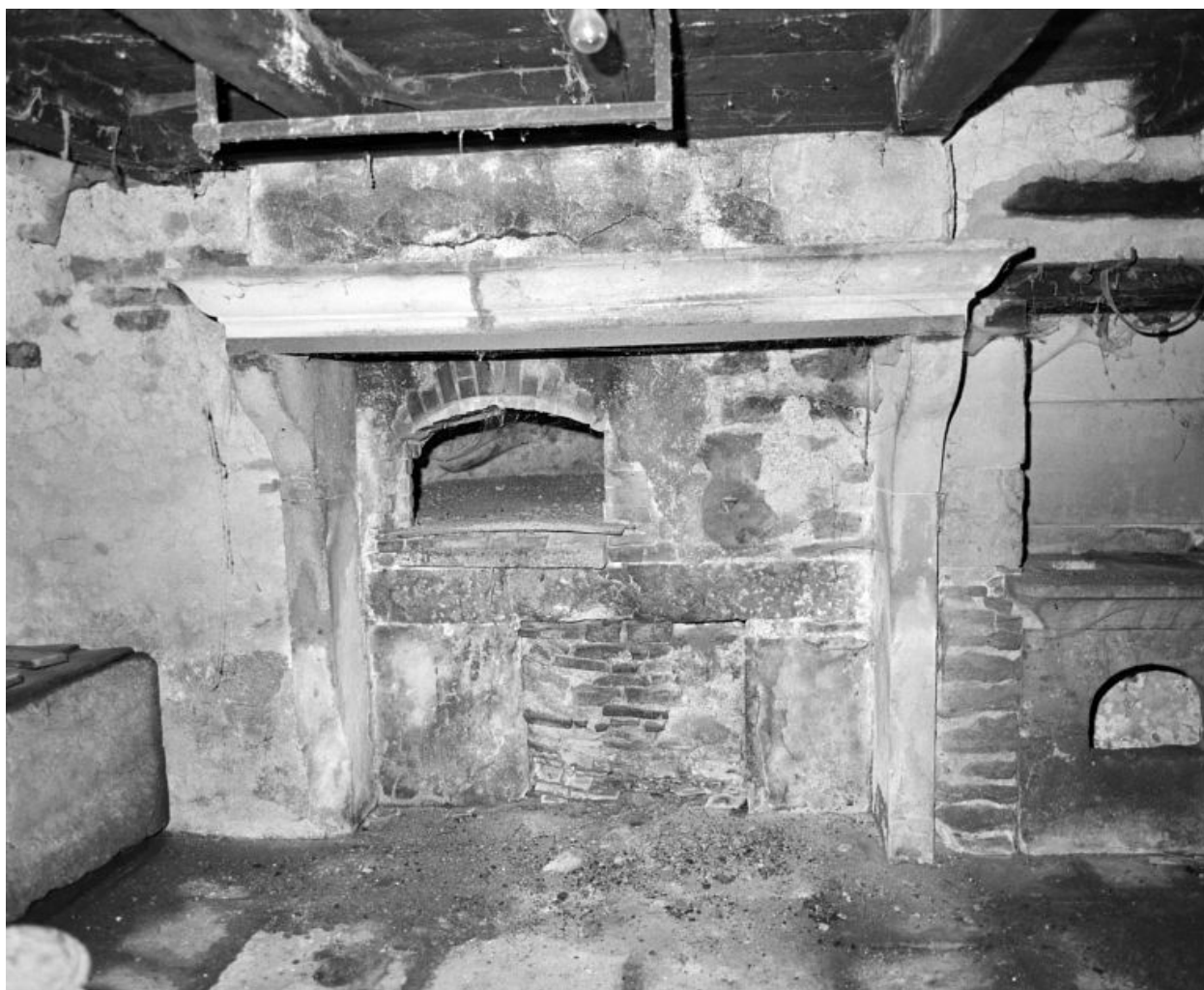
La chambre à four. La cheminée, détail.
