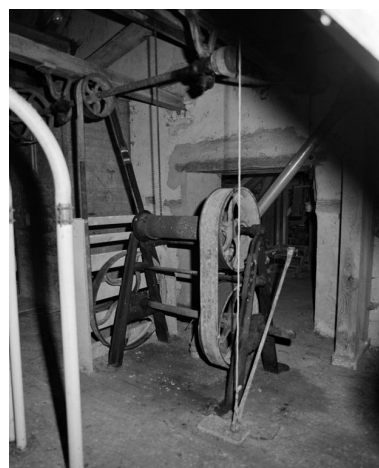
Comble à surcroît. Monte-sacs. Phot. Jean-Luc Duthu IVR26_20062106752X
