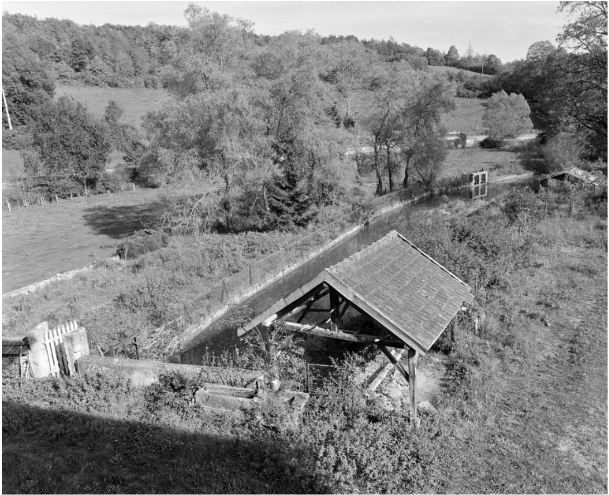
La retenue canalisée de la Coquille et le lavoir. Vue d'ensemble prise depuis le bâtiment gauche du moulin.
