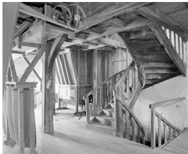
1er étage. Escalier. Phot. Jean-Luc Duthu IVR26_20062106708X
