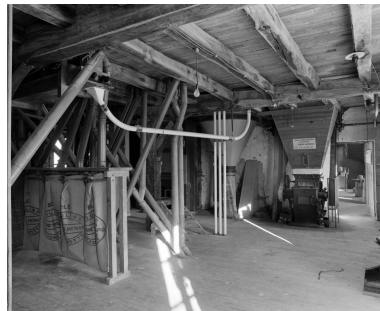
1er étage. Broyeur et ensacheur. Phot. Jean-Luc Duthu IVR26_20062106690X
