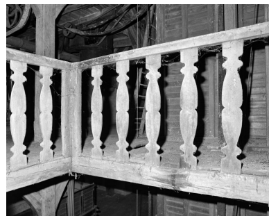
2e étage. Escalier, détail de la balustrade du palier. Phot. Jean-Luc Duthu IVR26_20062106715X
