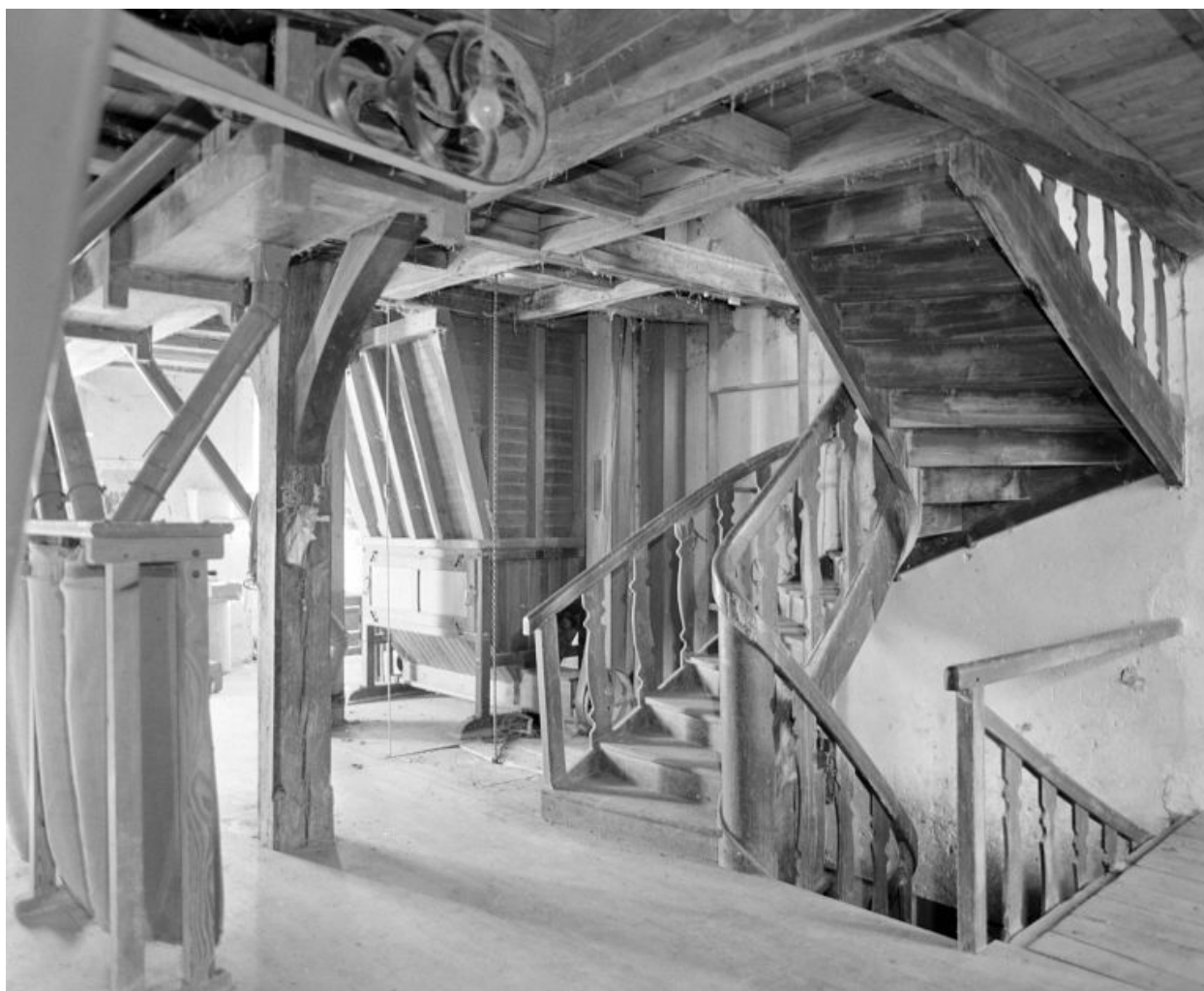
1er étage. Escalier.
