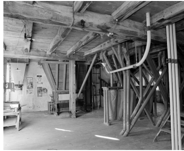
1er étage. Boisseau et ensacheur. Phot. Jean-Luc Duthu IVR26_20062106684X
