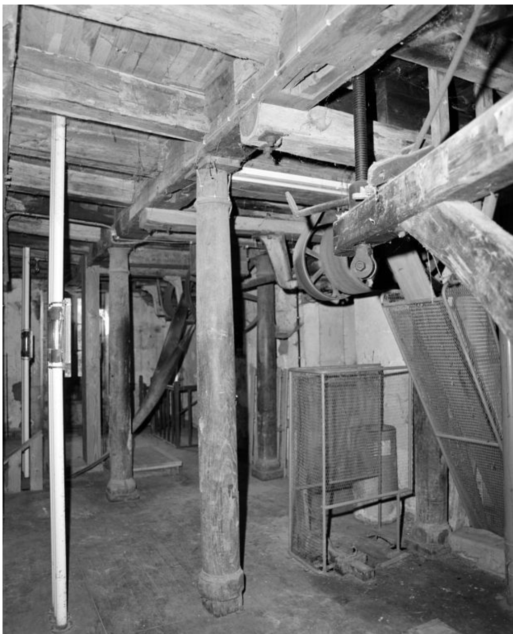
Rez-de-chaussée. Arbre de transmission et poulies.
