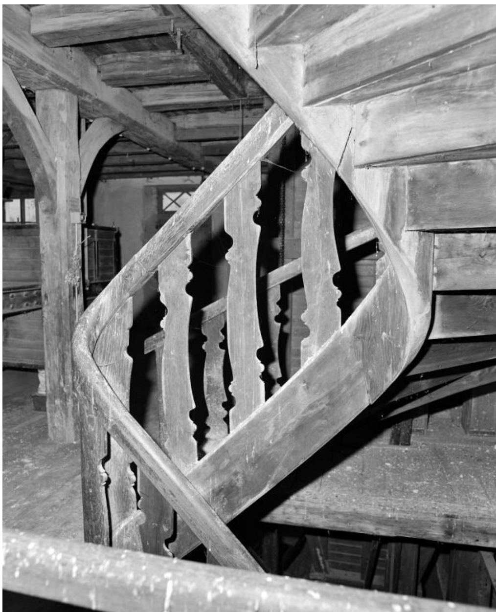
2e étage. Escalier, détail de la volée.
