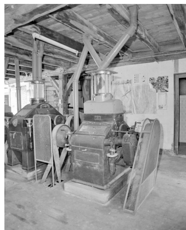
Rez-de-chaussée. Broyeurs (Ateliers de construction Camus frères, ingénieurs, Tonnerre et Socam, Paris), détail. Phot. Jean-Luc Duthu IVR26_20062106656X
