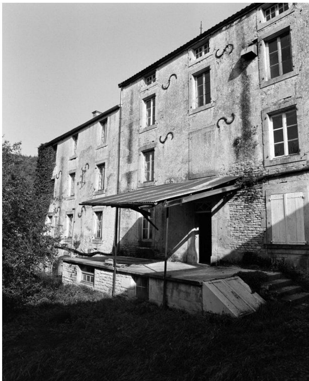
Les bâtiments principaux. Elévations postérieures.
