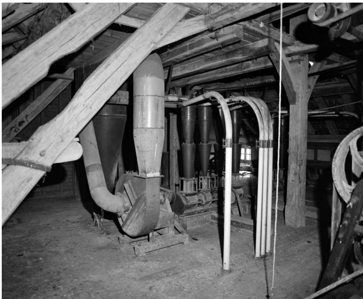
Comble à surcroît. Ecluses.
