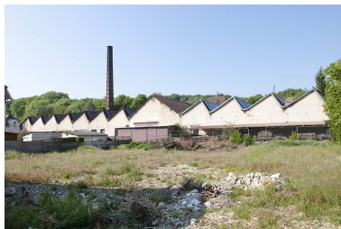
Atelier de laitonnerie. Façade ouest. Phot. Jérôme Mongreville IVR43_20112501391NUC4A
