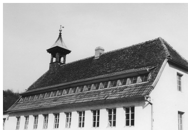
Toiture de l'atelier de fabrication en 1980. Photogr., 1980. Phot. Raphaël Favereaux, Autr. Bernard Goetz IVR43_20122500681NUC2A
