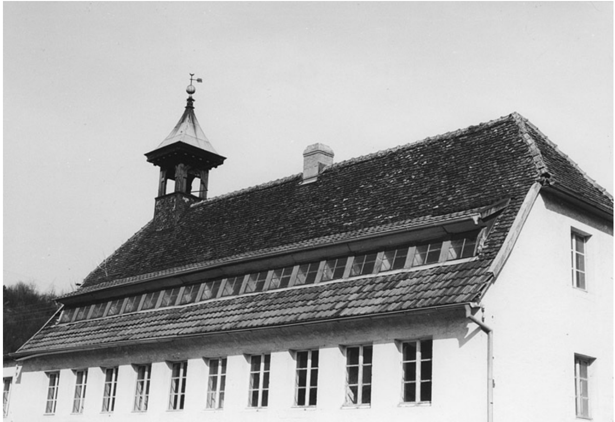
Toiture de l'atelier de fabrication est en 1980. Photogr., 1980.
