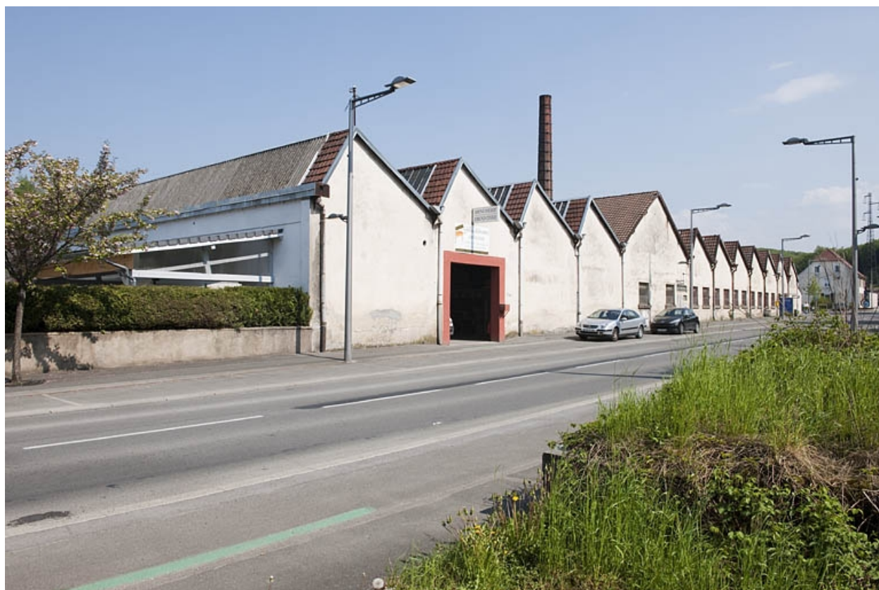
Atelier de laitonnerie depuis le nord-ouest.
