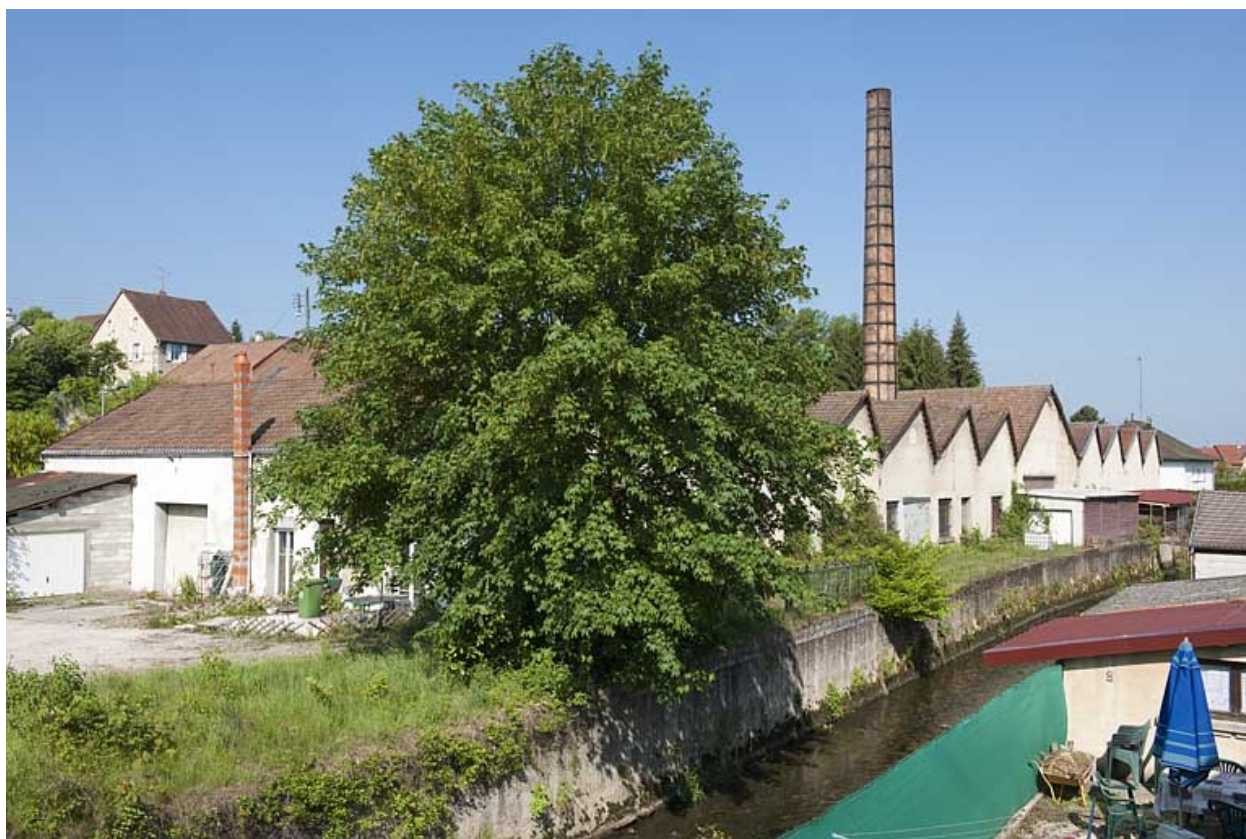
Atelier de laitonnerie. Vue depuis le sud-est.
