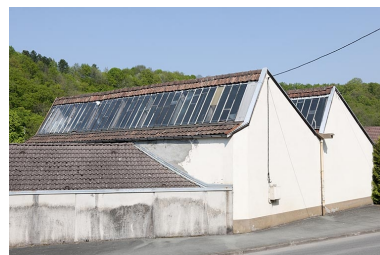
Vestiges d'un atelier d'horlogerie. Phot. Jérôme Mongreville IVR43_20112501427NUC4A
