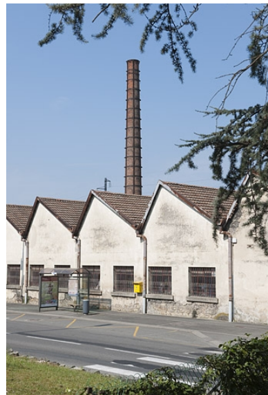
Vue rapprochée de l'atelier de laitonnerie. Phot. Jérôme Mongreville IVR43_20112501386NUC4A
