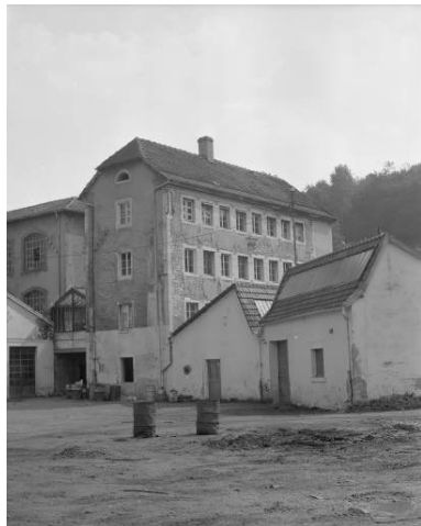
Elévation d'un ancien atelier en 1981. Phot. Yves Sancey IVR43_19812500463X
