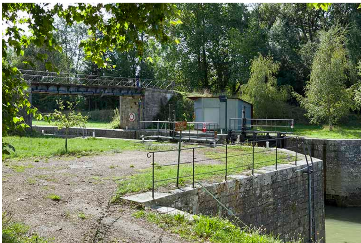
Le poste de commande de l'écluse.
