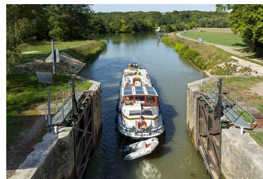
Bateau venant de franchir l'écluse. Phot. Sonia Dourlot IVR43_20157000884NUC2A
