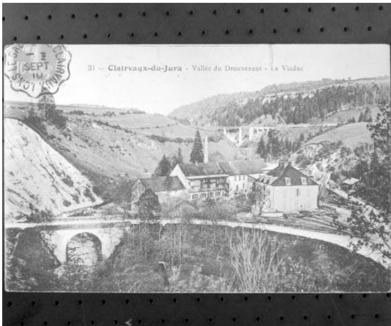
Clairvaux-du-Jura - Vallée du Drouvenant - Le Viaduc.
