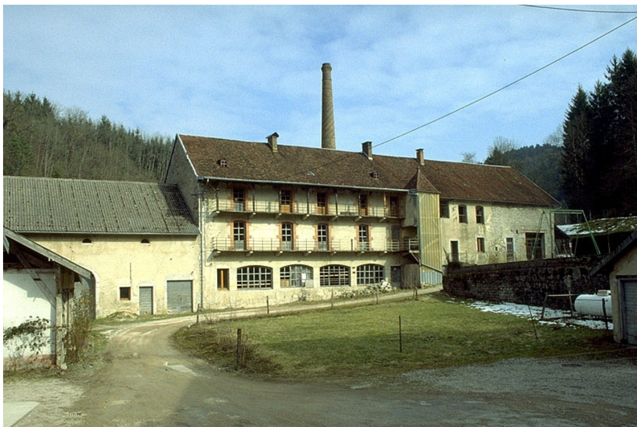
Façades antérieures de l'usine. Au second plan de gauche à droite : parties agricoles, atelier de fabrication et logement, remise à automobile.
