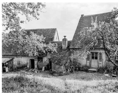
Partie gauche de la façade postérieure. Phot. Dominique Dominguez IVR43_19773900020X
