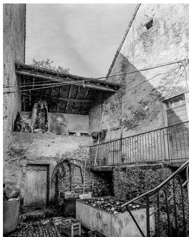
La cour entre les deux bâtiments. Phot. Dominique Dominguez IVR43_19773900022X
