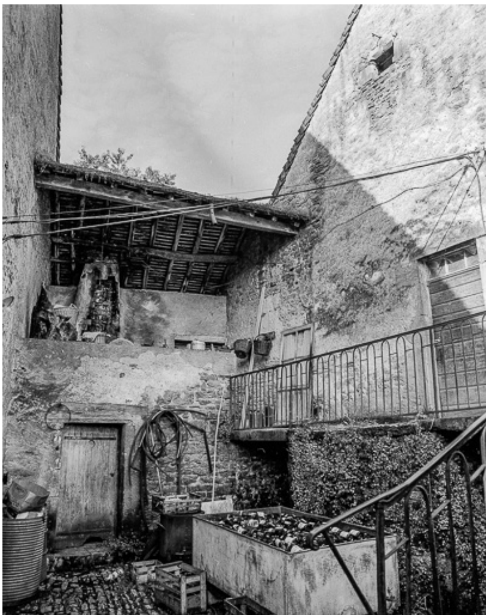
La cour entre les deux bâtiments.
