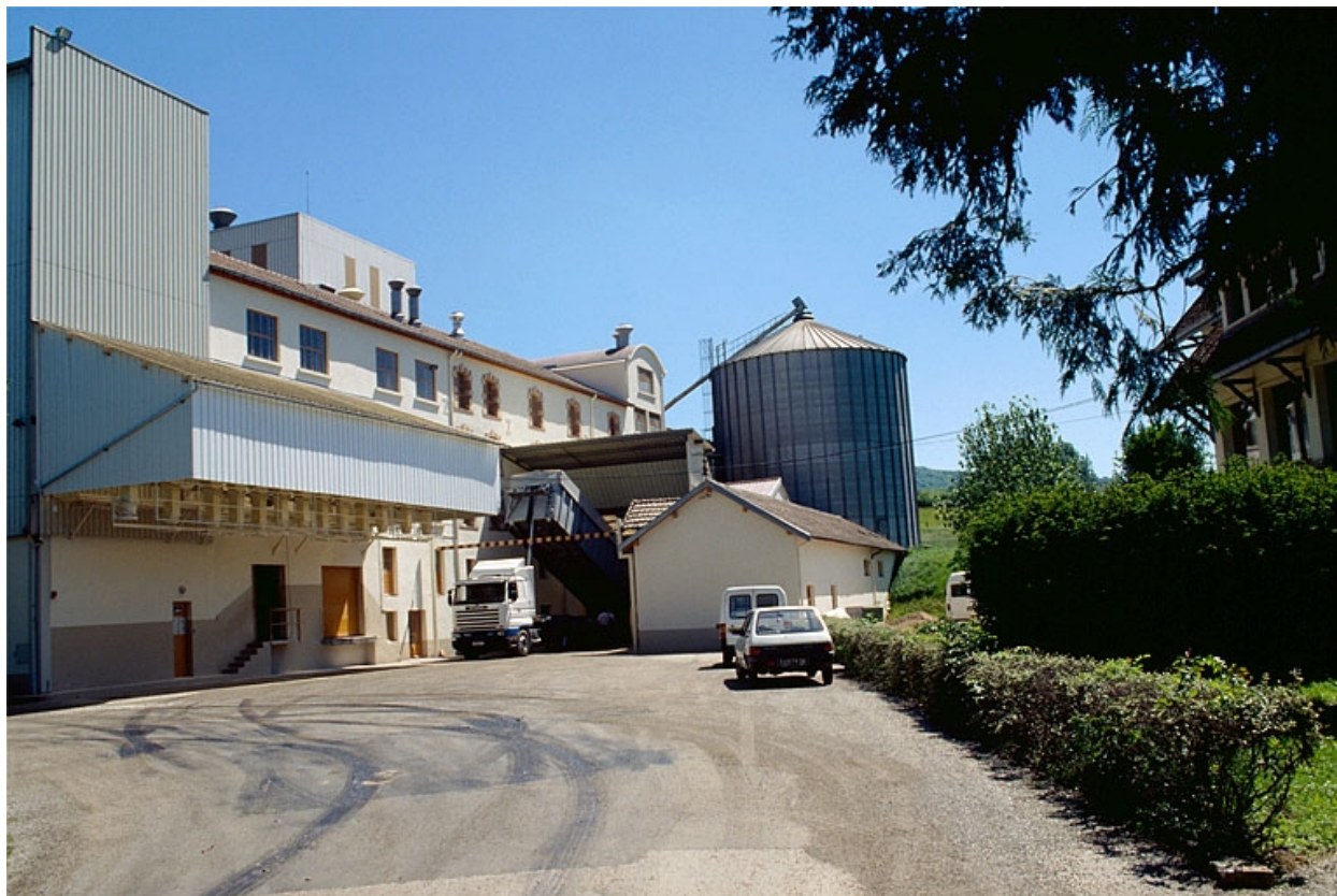
Atelier de fabrication et silos depuis l'entrée.
