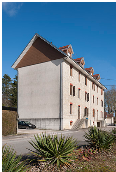
Immeuble de logements. Vue d'ensemble. Phot. Jérôme Mongreville IVR43_20152500347NUC4A
