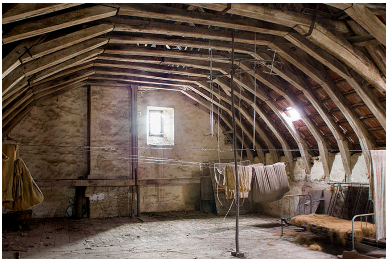
Vue générale de la charpente.
