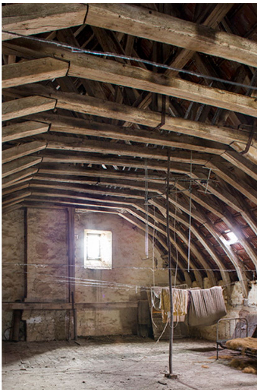
Vue rapprochée de la charpente.
